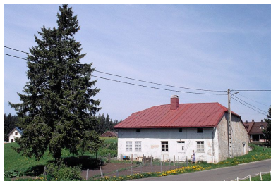
Vue générale. Phot. Yves Sancey IVR43_19993900081ZA
