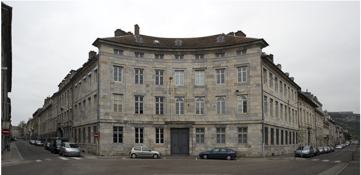
Vue d'ensemble avec l'alignement des rues.
