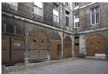
Vue des remises en rez- de-chaussée sur cour. Phot. Yves Sancey IVR43_20072500294NUCA
