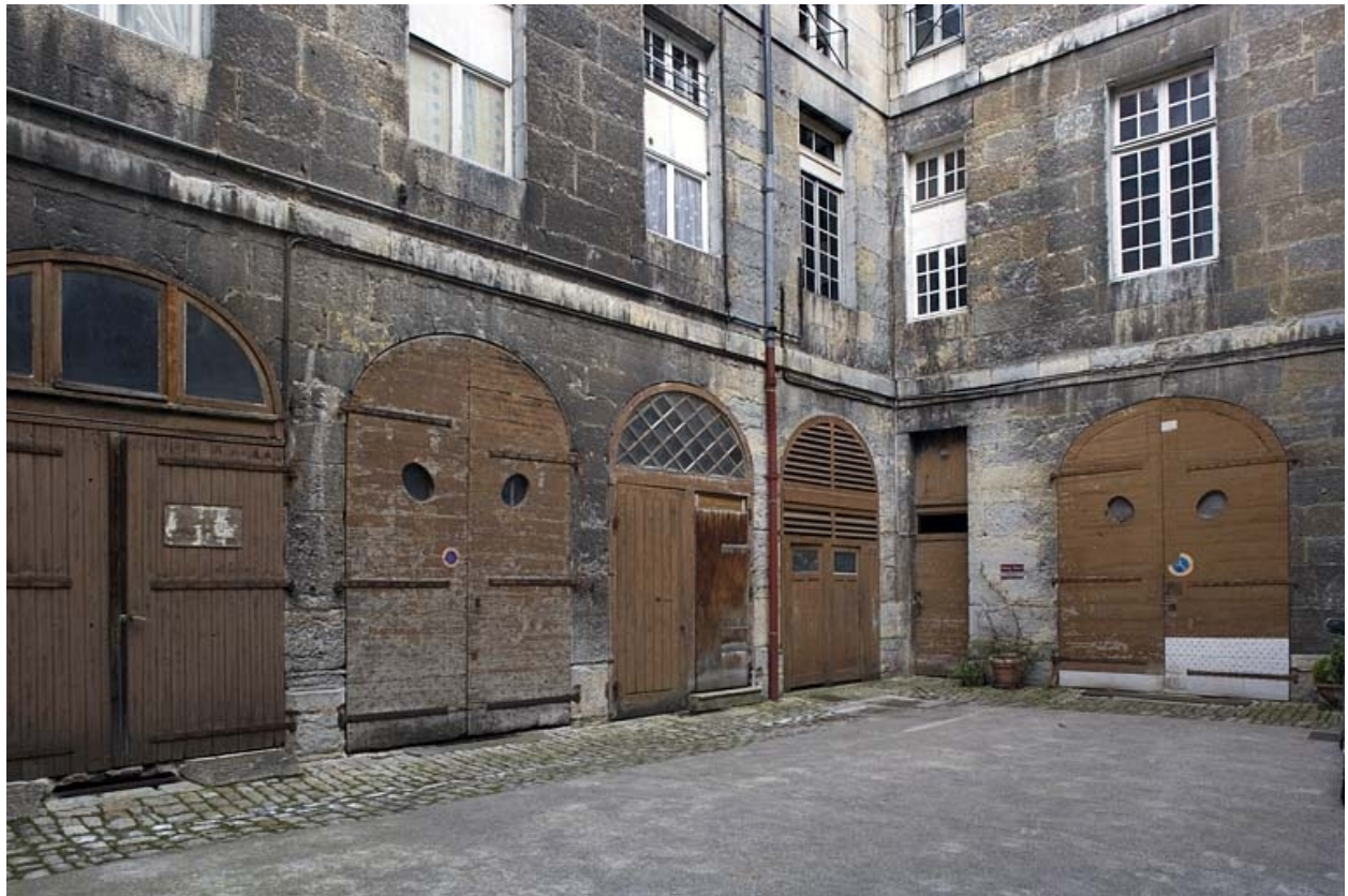
Vue des remises en rez-de-chaussée sur cour.
