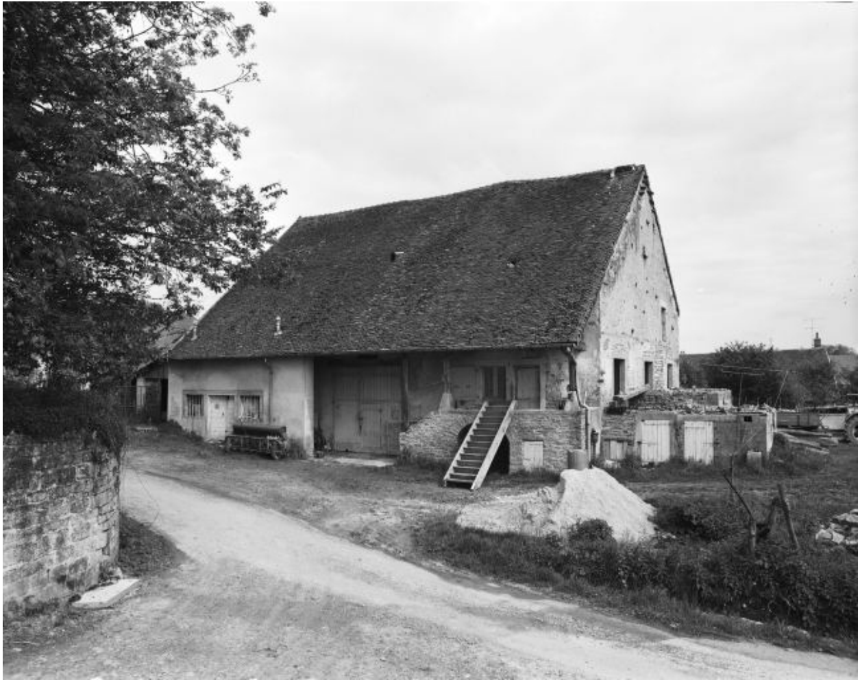
Ferme située rue Alfred Labordère.
