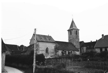
Eglise paroissiale Saint-Rémi. Phot. Guy Forestier IVR43_19743901022Z
