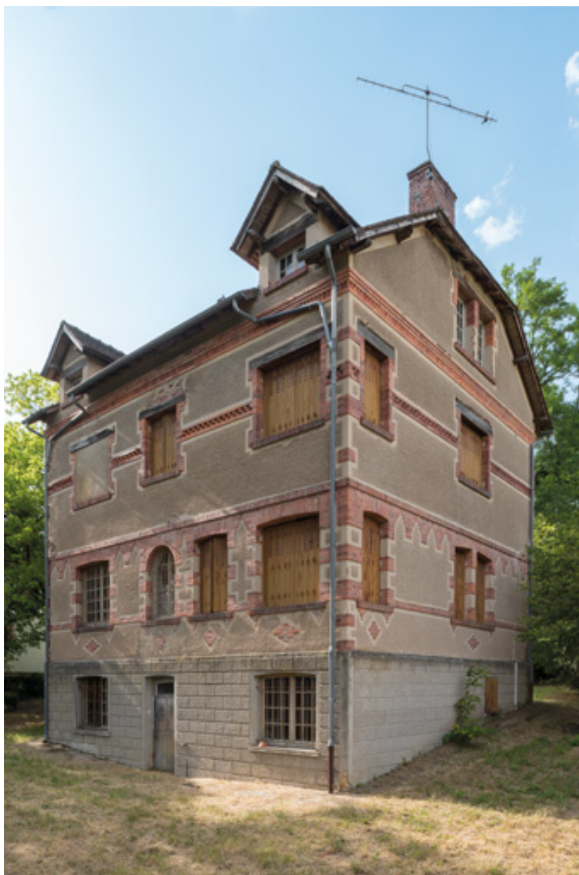
Façade postérieure, vue depuis le sud-est.
