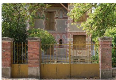
Portail sur l'actuelle avenue Jean Mermoz. Phot. Pierre-Marie Barbe-Richaud IVR26_20195800506NUC4A
