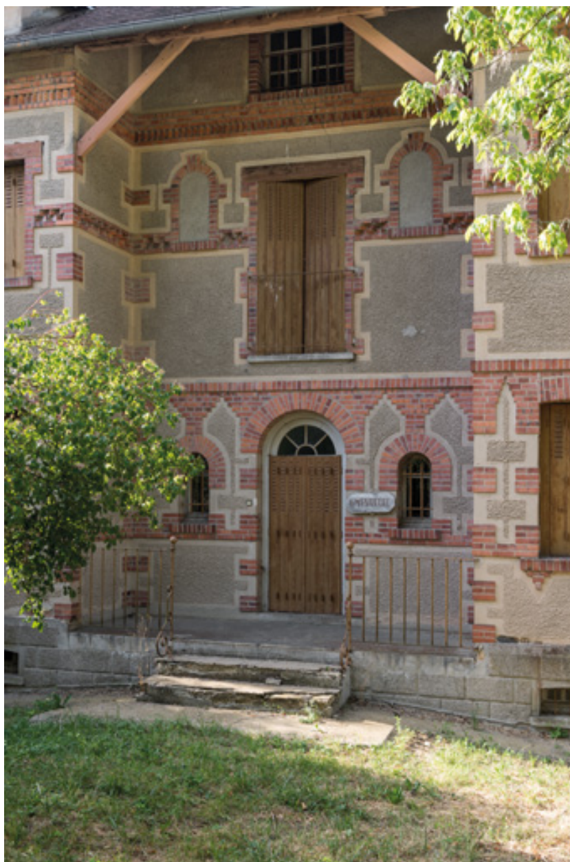
Façade principale, arrière-corps central.
