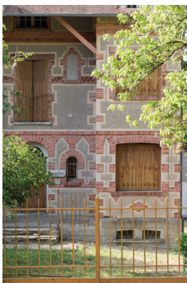
Façade principale, avant-corps latéral. Phot. Pierre-Marie Barbe-Richaud IVR26_20195800504NUC4A
