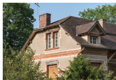
Détail de la toiture, demi-croupe et lucarne. Phot. Pierre-Marie Barbe-Richaud IVR26_20195800501NUC4A
