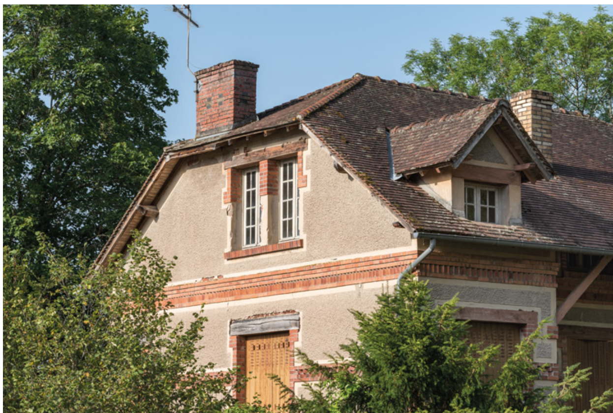
Détail de la toiture, demi-croupe et lucarne.
