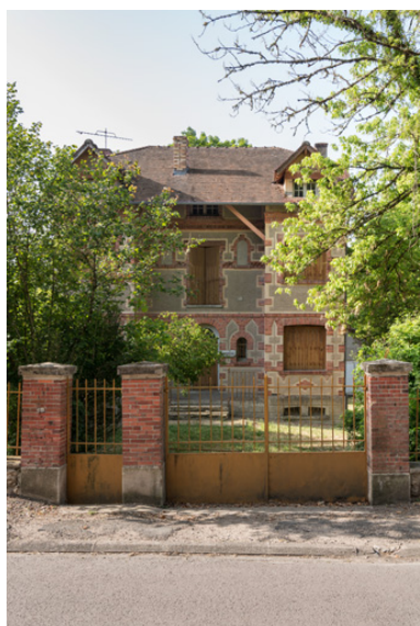
Portail sur l'actuelle avenue Jean Mermoz. Phot. Pierre-Marie Barbe-Richaud IVR26_20195800503NUC4A
