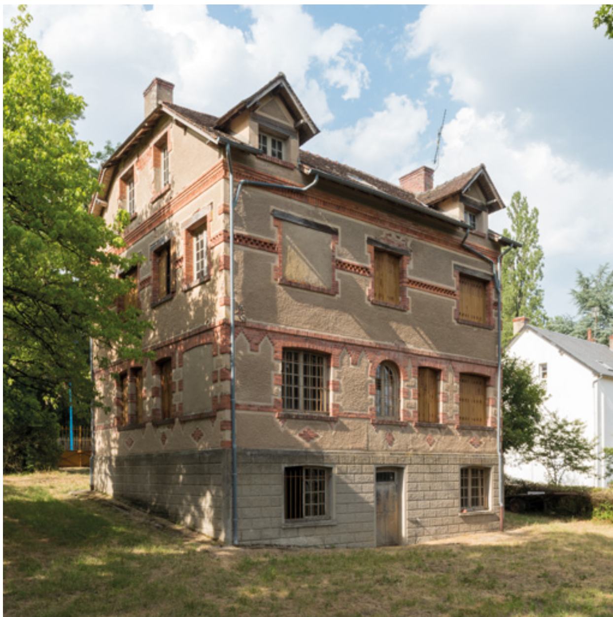
Façade postérieure, vue depuis le sud-ouest.
