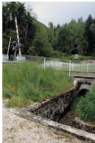
Tête aval (est) de l'aqueduc. Phot. Yves Sancey IVR43_20053900871ZA
