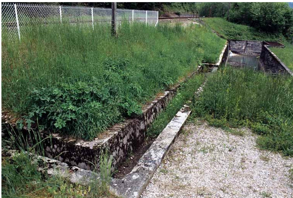
Canal reliant l'aqueduc au réservoir.
