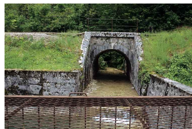
Tête aval (est) du pont. Phot. Yves Sancey IVR43_20053900867ZA
