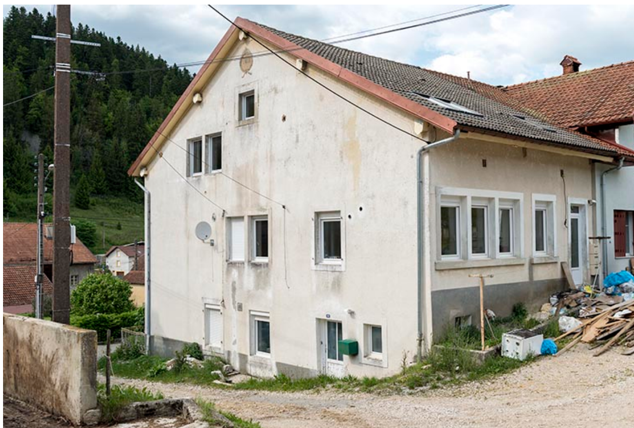
Bâtiment d'origine : façades postérieure et latérale droite.
