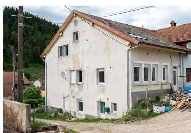
Bâtiment d'origine : façades postérieure et latérale droite.
