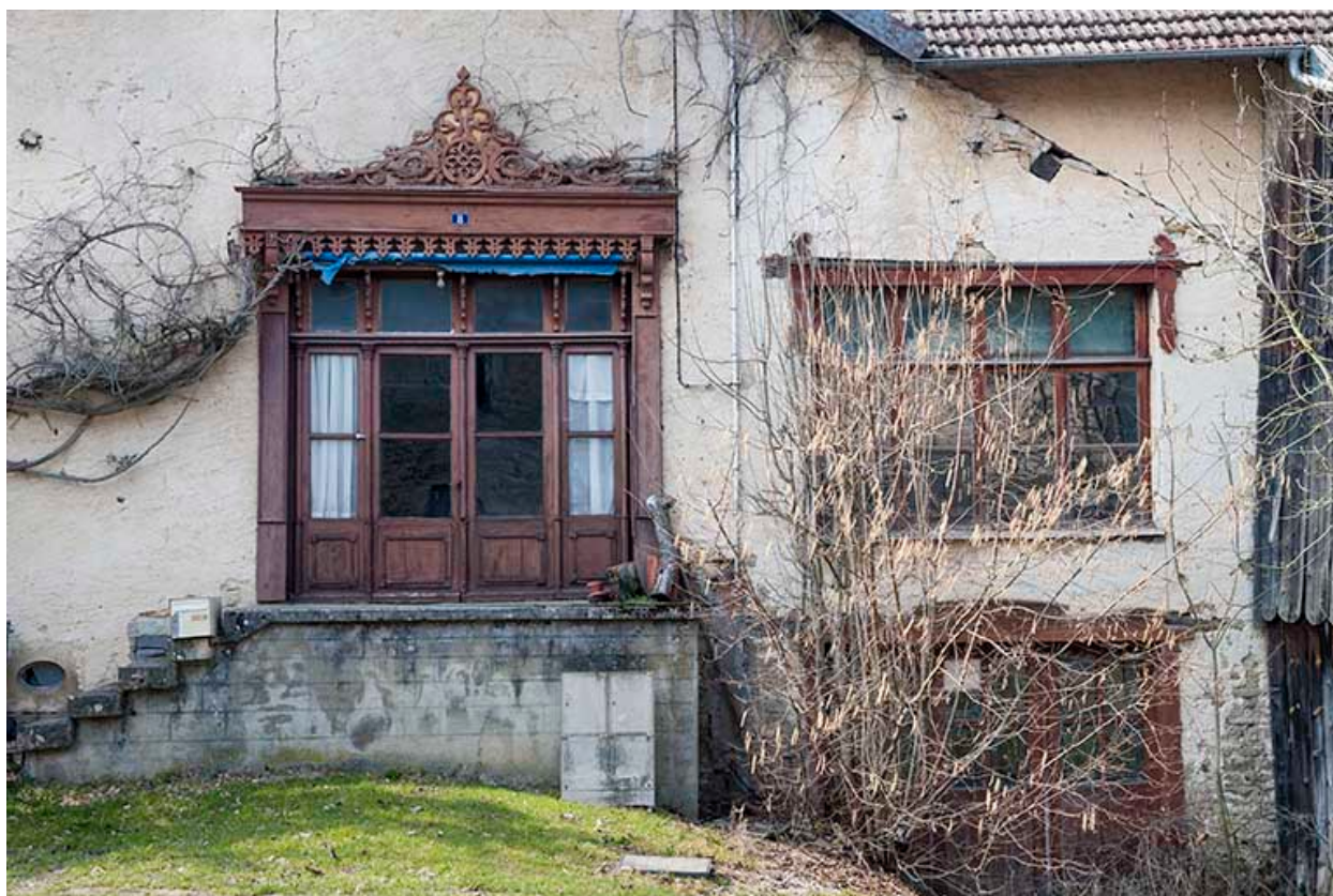
Façade sud. Entrées des ateliers.
