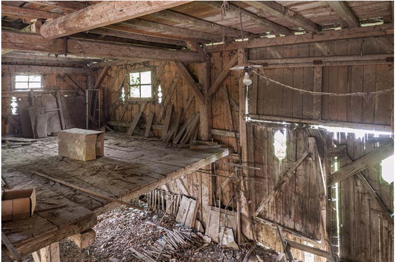
Magasin industriel. Vue depuis l'étage.
