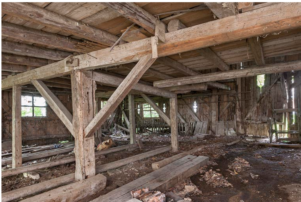
Entrepôt industriel. Rez-de-chaussée.
