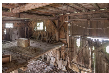
Magasin industriel. Vue depuis l'étage. Phot. Jérôme Mongreville IVR43_20142501293NUC4A
