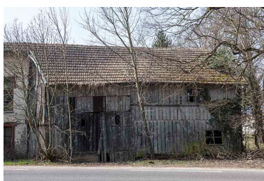
Façade est de l'entrepôt industriel. Phot. Jérôme Mongreville IVR43_20152500411NUC4A
