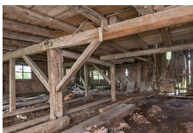
Entrepôt industriel. Rez-de-chaussée. Phot. Jérôme Mongreville IVR43_20142501291NUC4A
