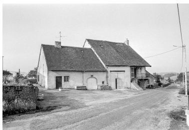
Ferme située à Pannessières. Phot. Bernard Pontefract IVR43_19763900307Z
