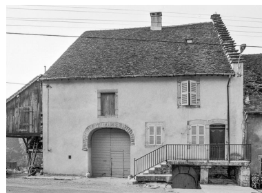
Ferme située à Pannessières. Phot. Bernard Pontefract IVR43_19763900300Z
