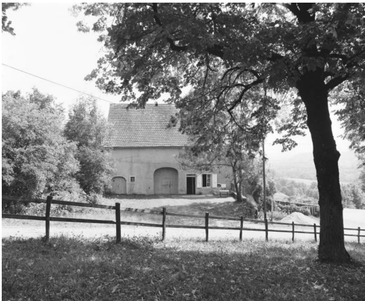
Ferme située à Châtillon.
