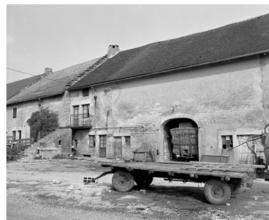
Ferme située à Nogna. Phot. Yves Sancey IVR43_19793900147X
