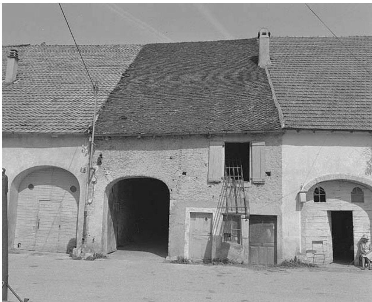
Ferme située à Châtillon.
