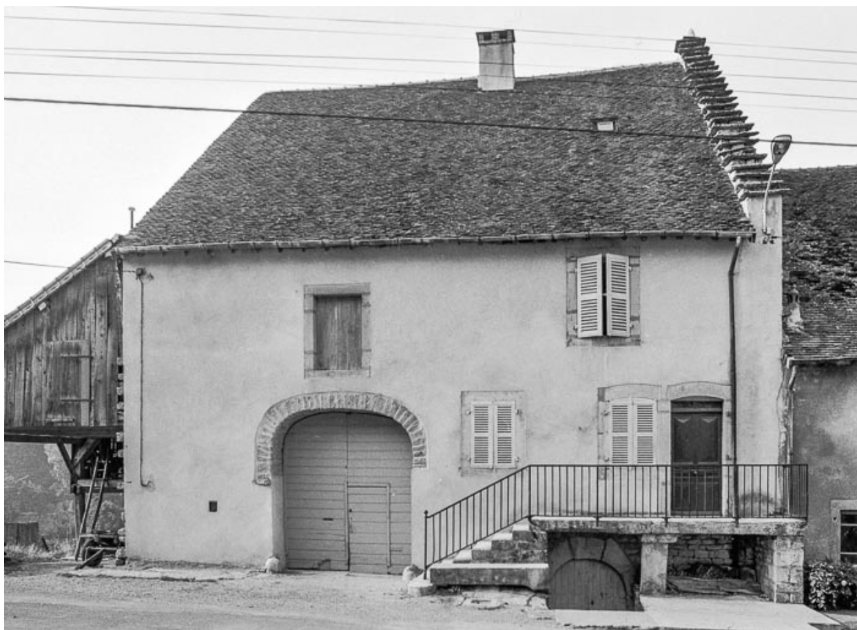
Ferme située à Pannessières.
