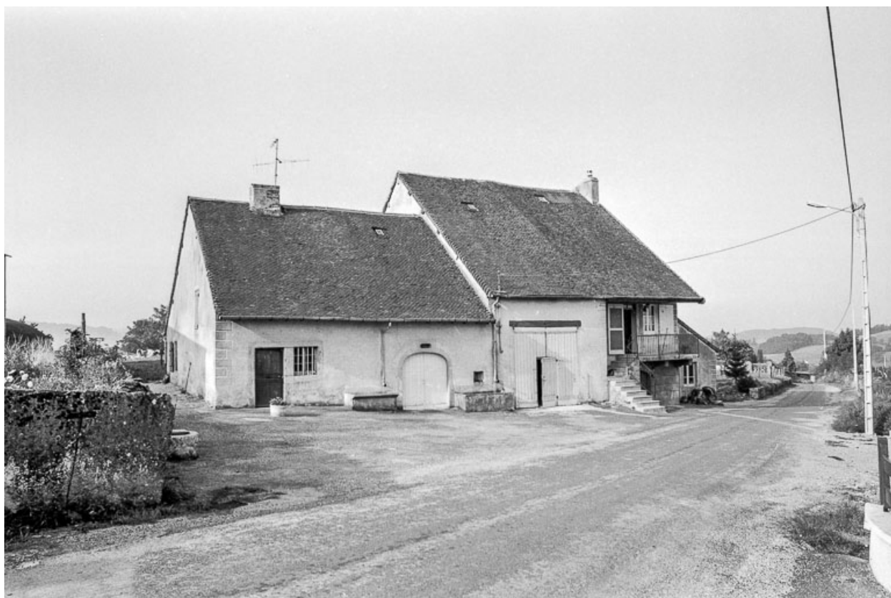
Ferme située à Pannessières.
