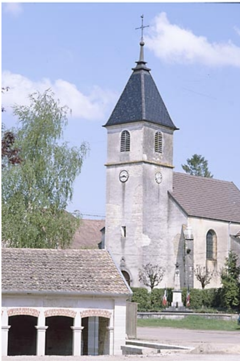
Façade antérieure dans le prolongement du lavoir.
