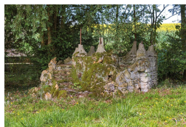
Kiosque rustique (vestiges). Phot. Pierre-Marie Barbe-Richaud IVR26_20245800197NUC4A
