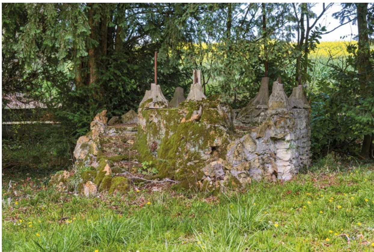
Kiosque rustique (vestiges).
