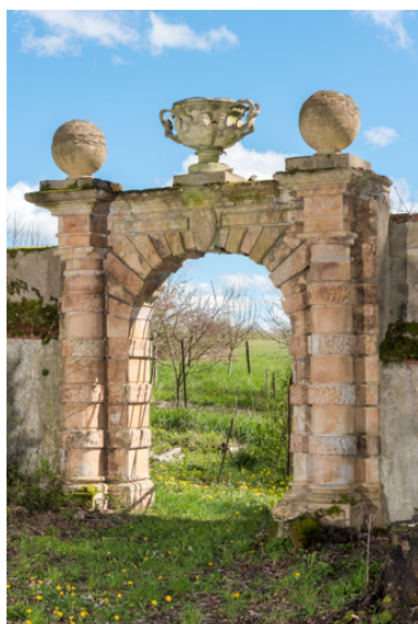
Portail du potager. Phot. Pierre-Marie Barbe-Richaud IVR26_20245800138NUC4A
