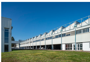
Façade est de l'atelier principal de fabrication. Phot. Jérôme Mongreville IVR43_20192500138NUC4A
