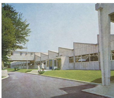
La nouvelle usine en 1962. IVR43_20212500083NUC2A
