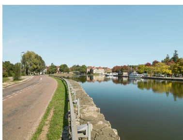
Vue du port et du pont en arrière plan. Phot. Pierre-Marie Barbe-Richaud IVR26_20177100384NUC2A
