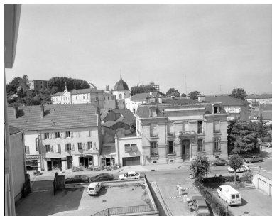
Vue d'ensemble éloignée. Phot. Yves Sancey IVR43_19917000262X
