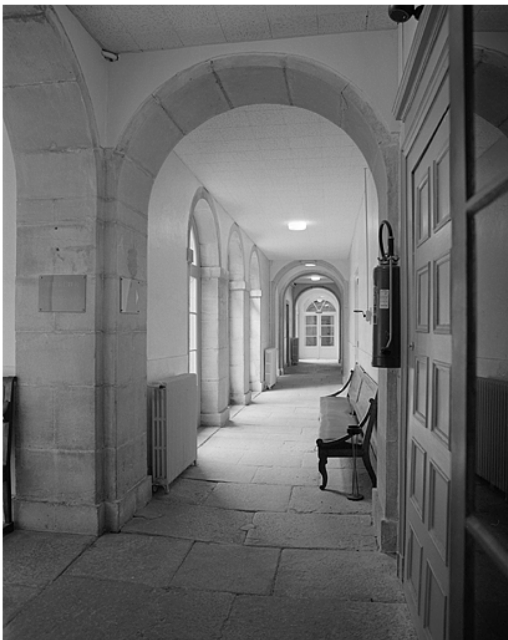
Galerie entourant une des cours intérieures.
