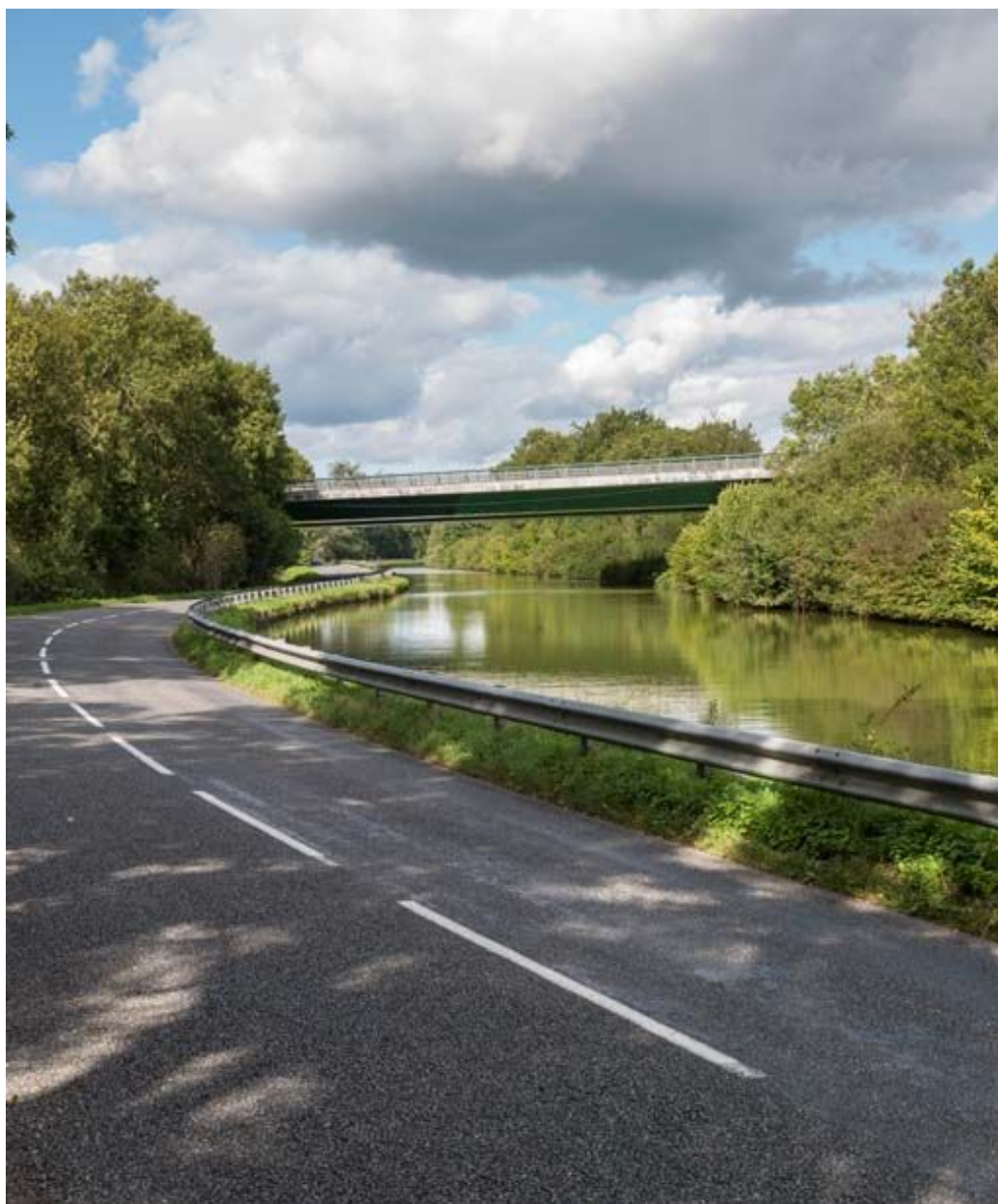
Vue d'ensemble du pont.
