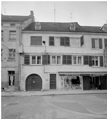
Façade sur rue de la maison de gauche. Phot. Jérôme Mongreville IVR43_19872501236V
