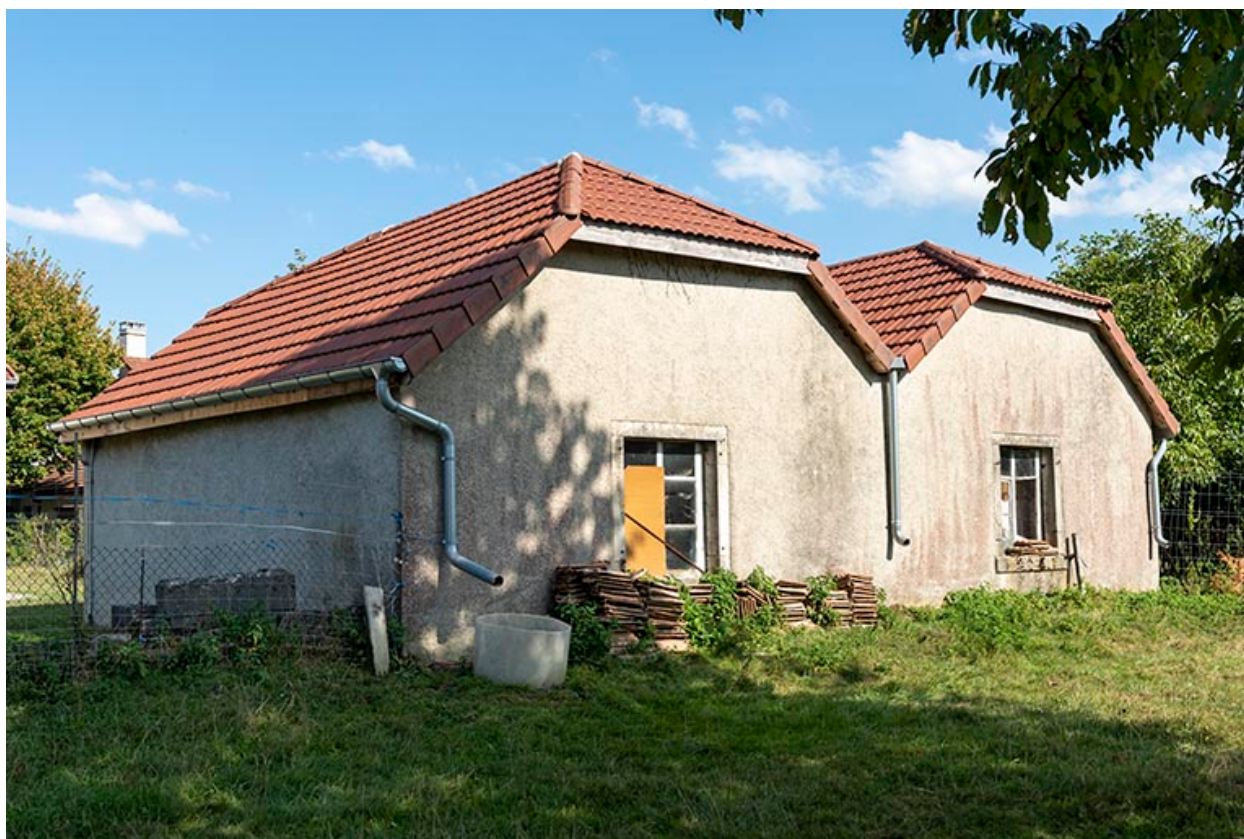
Forges : façade postérieure, de trois quarts gauche.
