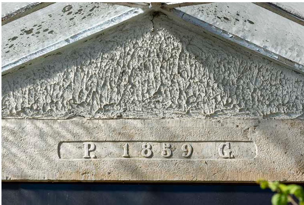
Maison au n° 45 : linteau daté.
