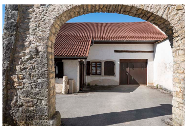
Maison au n° 47, depuis l'entrée. Phot. Sonia Dourlot IVR43_20192501278NUC4A
