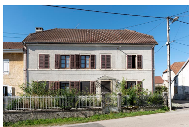
Maison au n° 45. Phot. Sonia Dourlot IVR43_20192501274NUC4A
