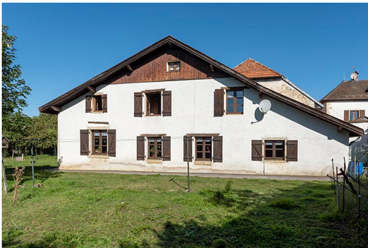
Maison au n° 47 : façade latérale gauche.
