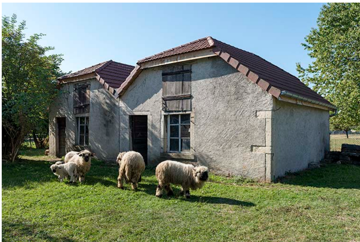
Forges : façade antérieure, de trois quarts droite.
