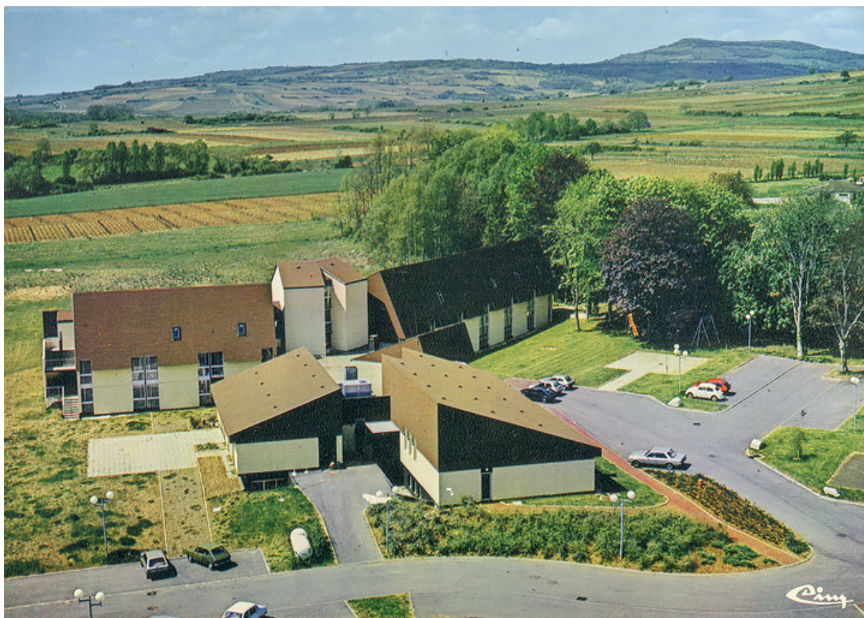
Centre thermal de 1978.
