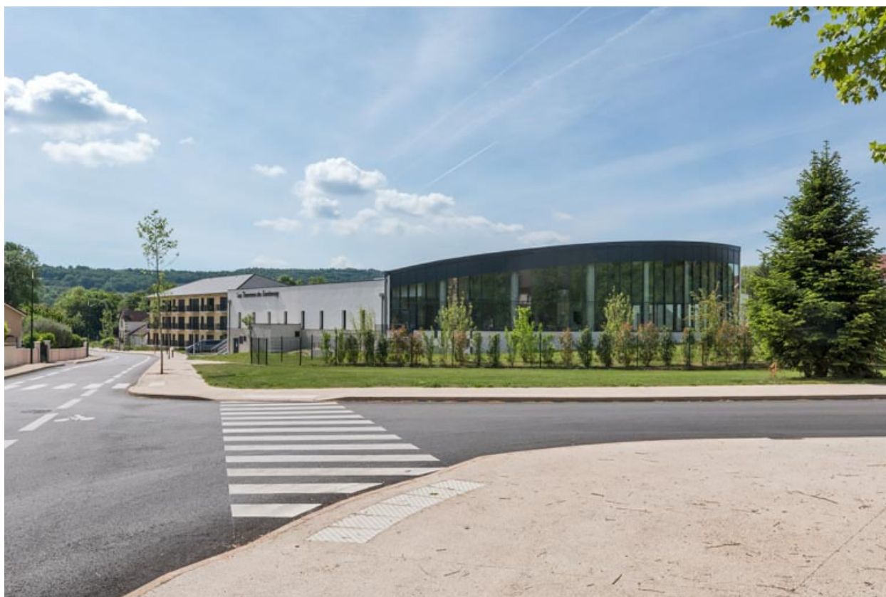
Centre thermal de 2021.
