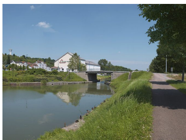
Vue d'ensemble d'aval. Phot. Thierry Kuntz IVR26_20135800332NUC4A
