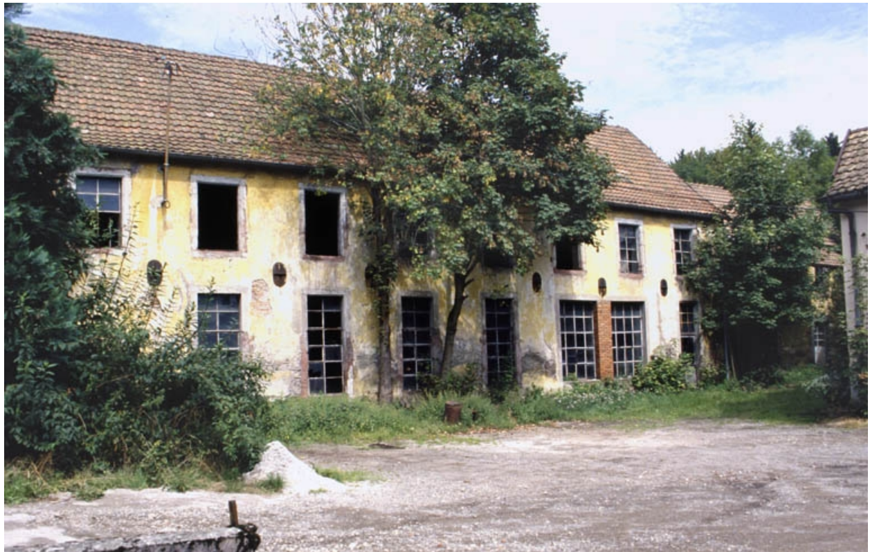
Atelier de réparation depuis la cour.
