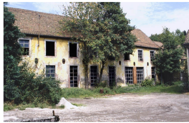
Atelier de réparation depuis la cour.
