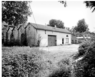
Salle des machines et chaufferie depuis l'ouest.
