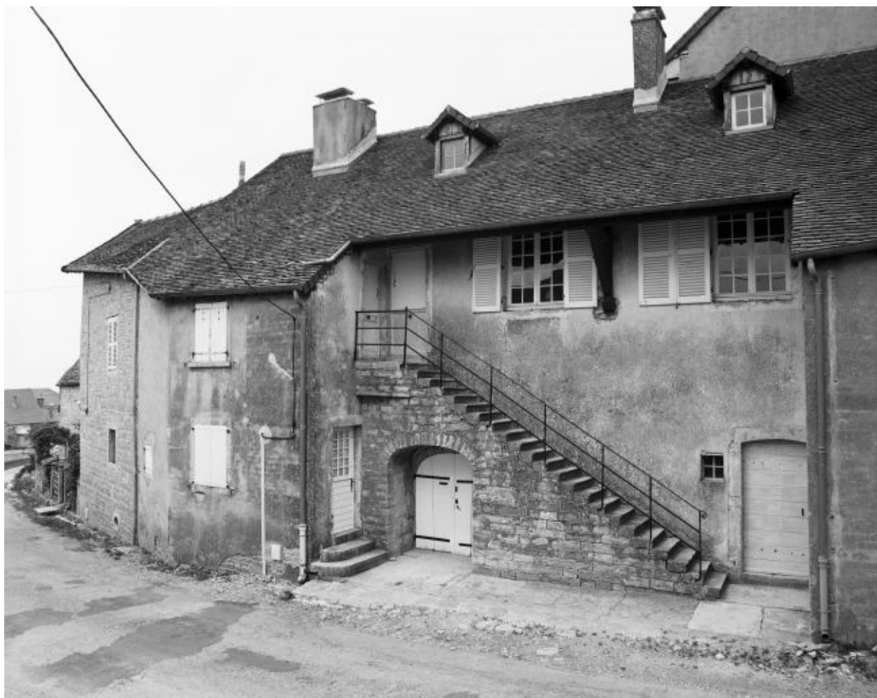
Maison située Grande Rue.
