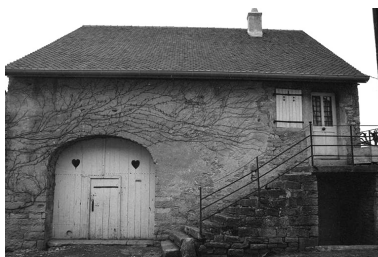
Maison de vigneron située rue de la Roche. Phot. F. Pernin IVR43_19743900134Z
