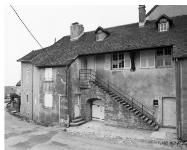
Maison située Grande Rue. Phot. Yves Sancey IVR43_19813900052X
