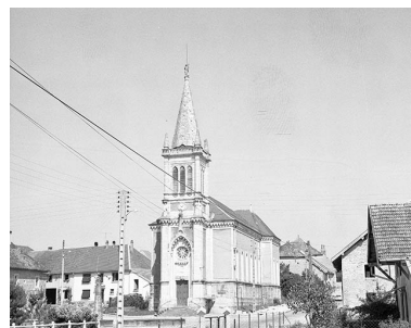
Extérieur : face antérieure. Phot. Yves Sancey IVR43_19752500510X
