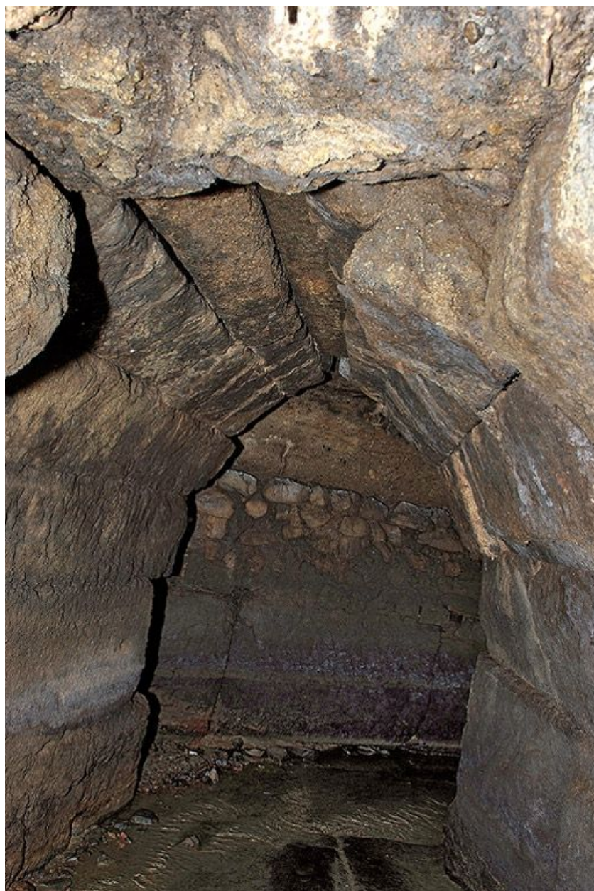
Section reliant les deux galeries.
