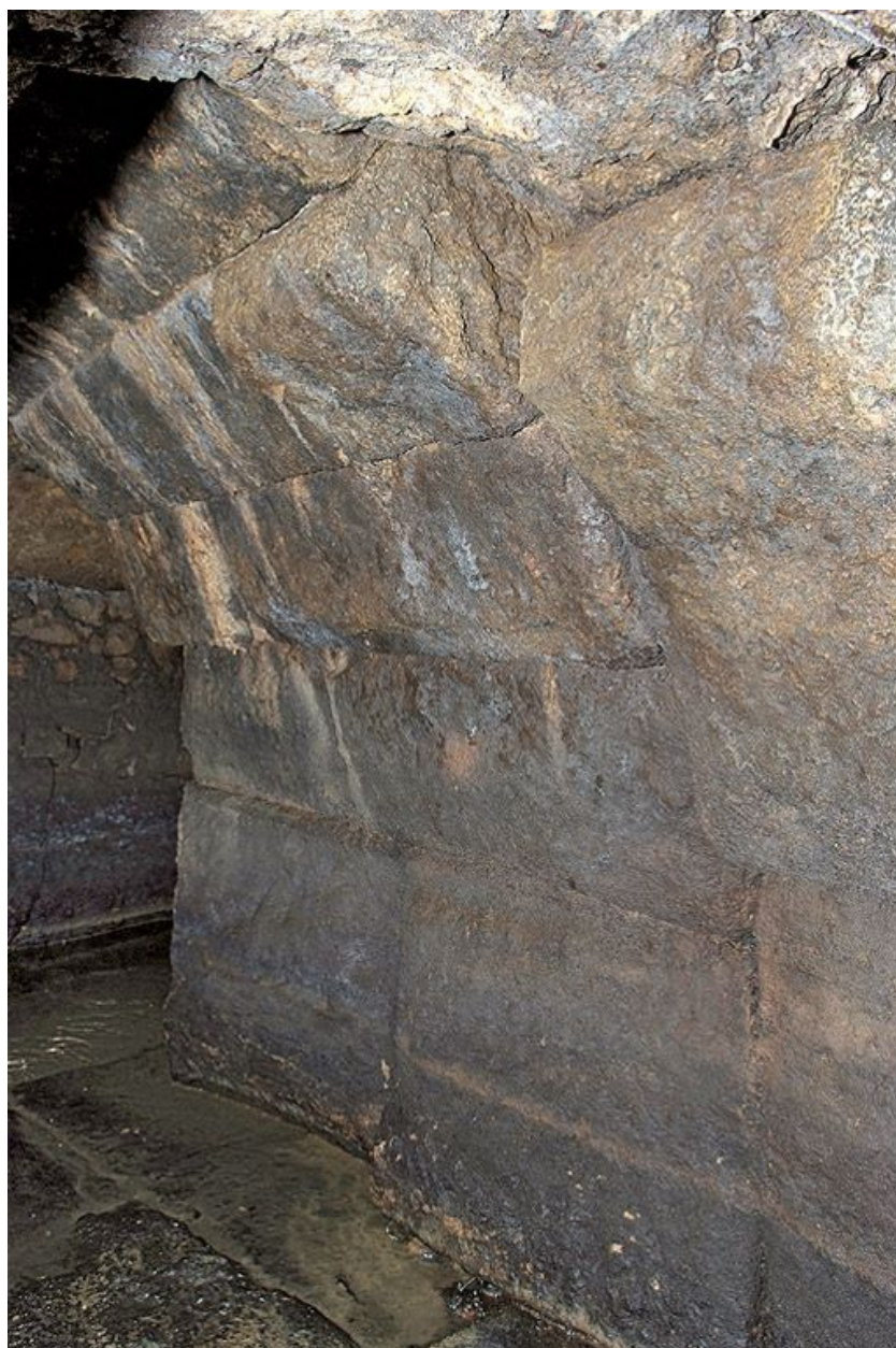
Section reliant les deux galeries.
