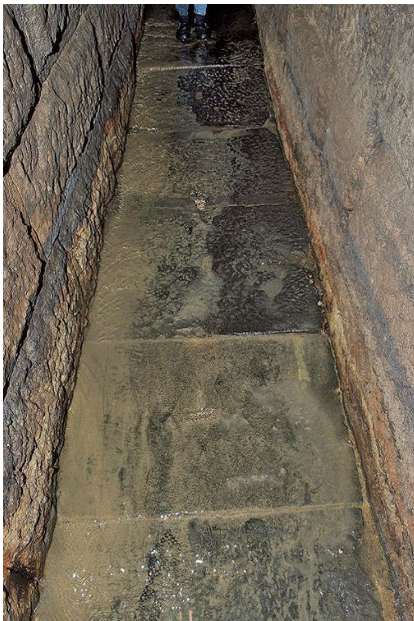
Deuxième galerie : détail des dalles du sol.
