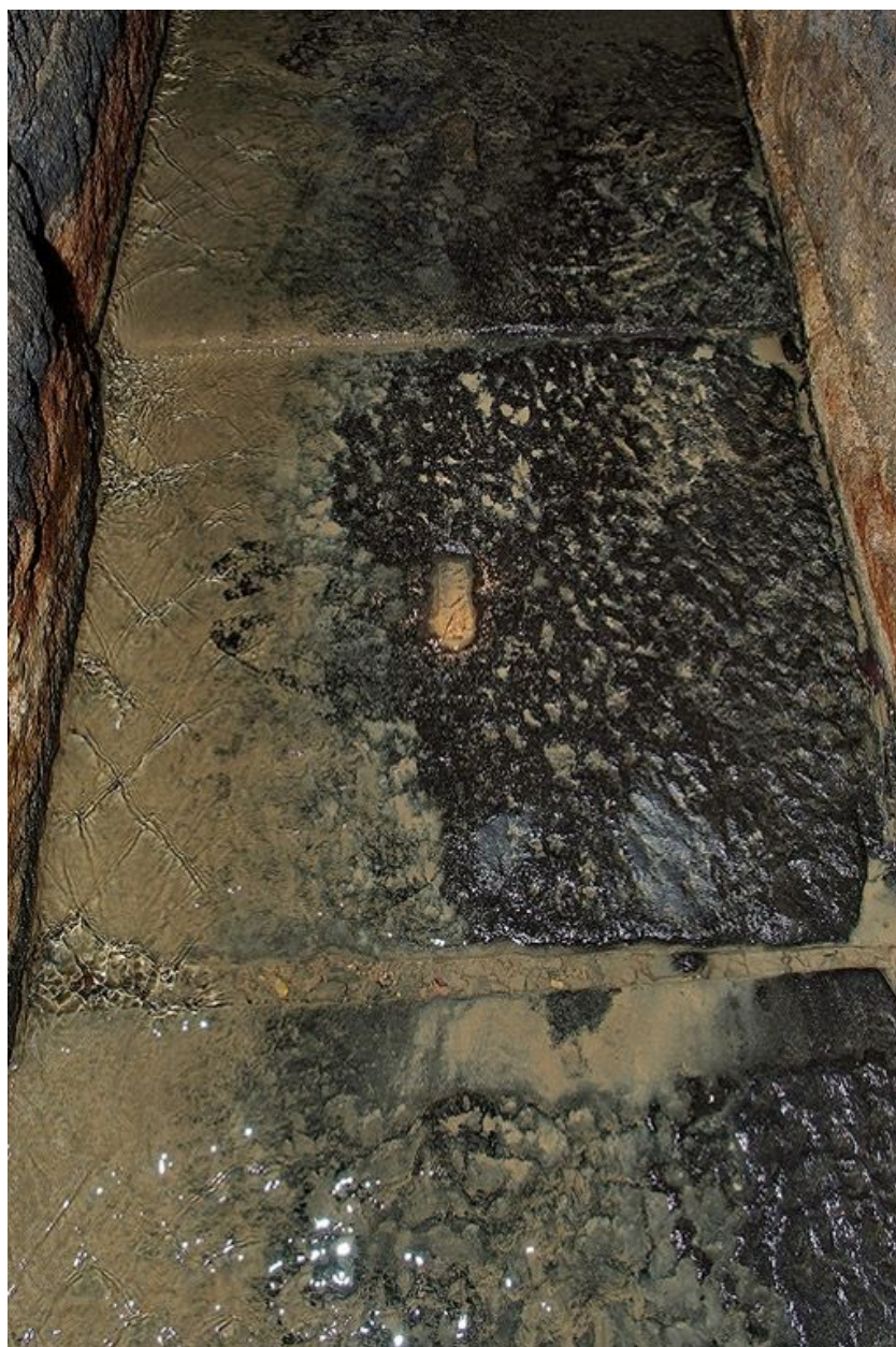
Deuxième galerie : détail des dalles du sol.
