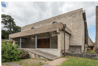
Façade antérieure de l'église. Vue de trois quarts. Phot. Pierre-Marie Barbe-Richaud
