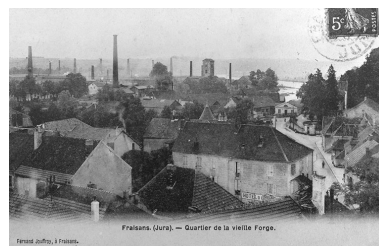
Fraisans (Jura) - Quartier de la vieille Forge. Phot. Yves Sancey IVR43_19883900189V
