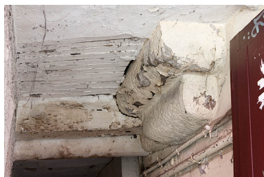
Logis principal : détail d'un encorbellement de cheminée dans le couloir d'entrée. Phot. Jérôme Mongreville IVR43_20112500140NUC4A
