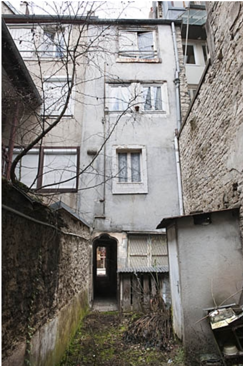
Logis principal : façade postérieure, de face.
