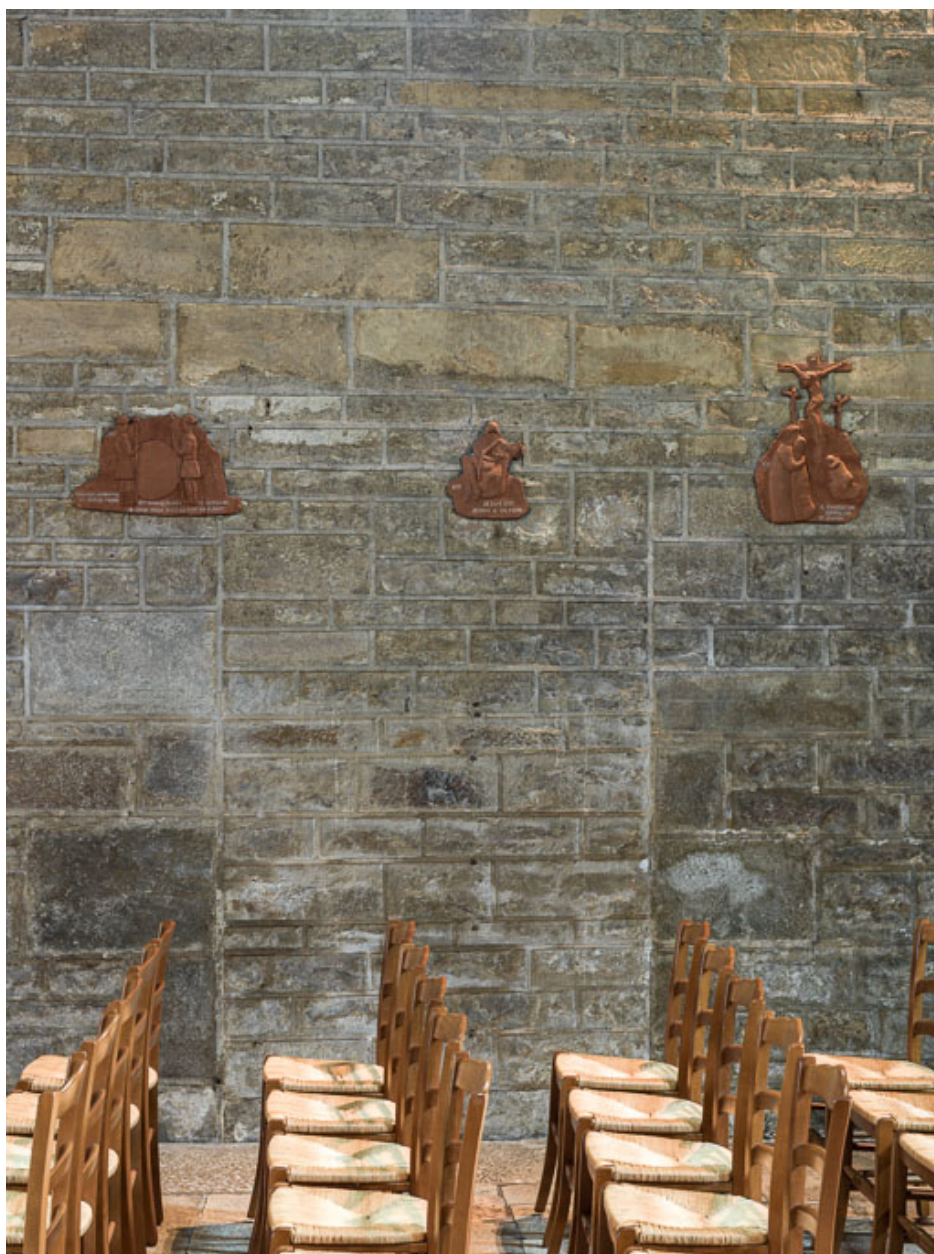
Porte murée, bras nord de la nef.
