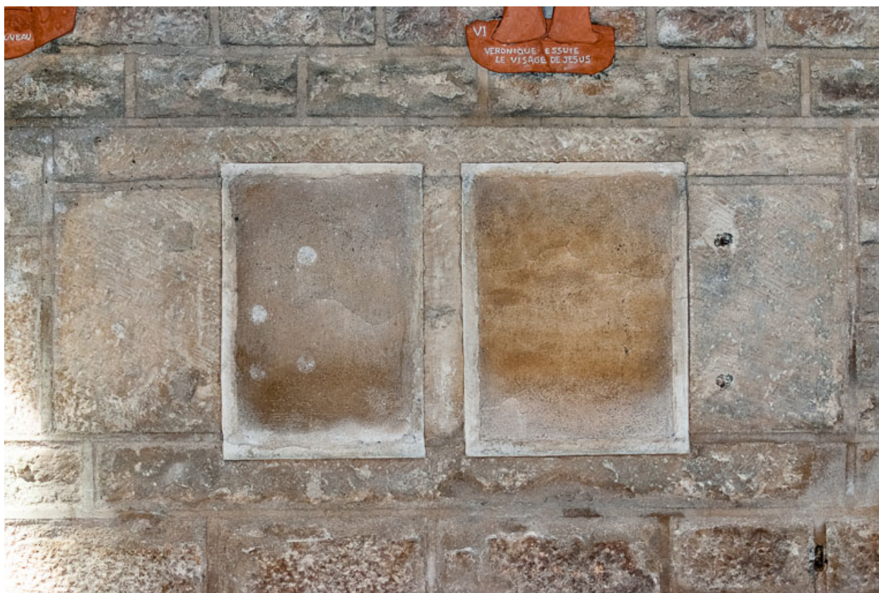
Lavabos murés, mur nord de la nef.
