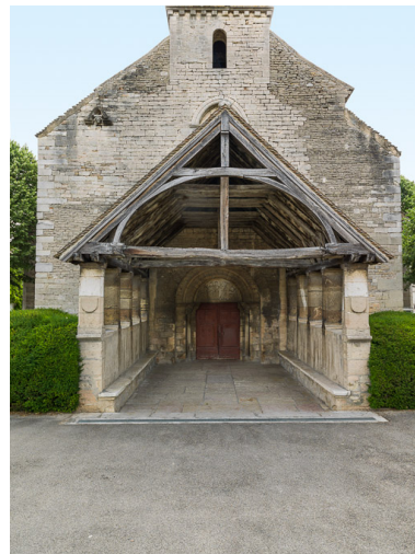
Porche : vue de face. Phot. Pierre-Marie Barbe-Richaud IVR26_20152100417NUC4A
