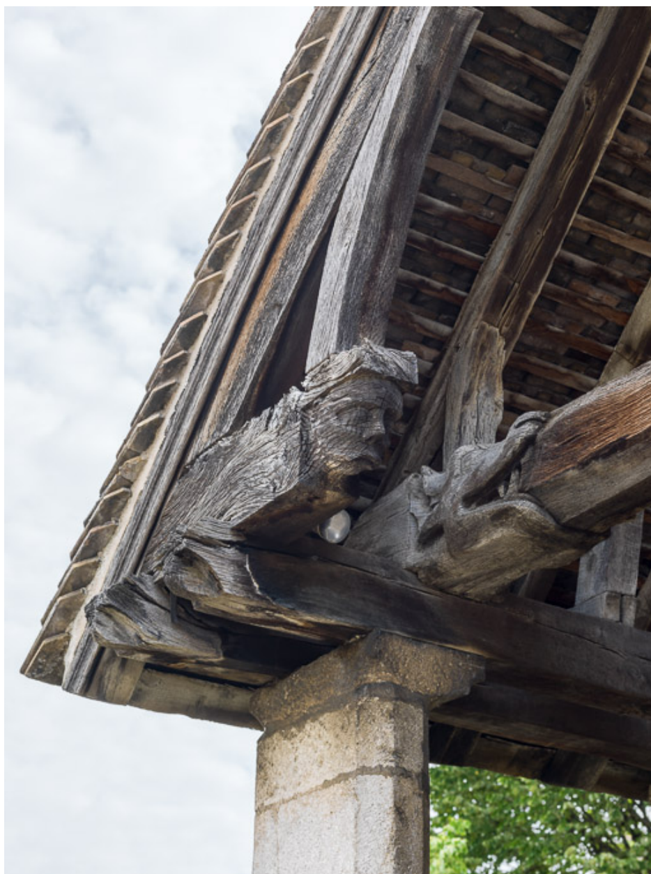
Porche : détail d'un engoulant.
