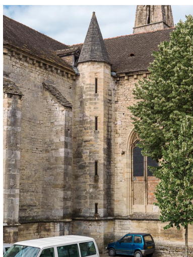
Vue de la tourselle d'escalier.
