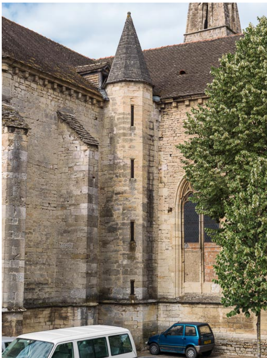
Vue de la tourelle d'escalier.
