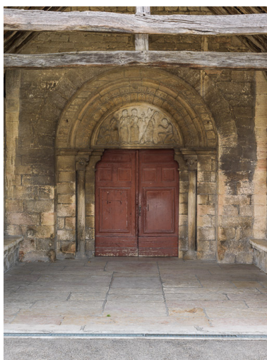
Porche : vue du portail et du tympan. Phot. Pierre-Marie Barbe-Richaud IVR26_20152100422NUC4A
