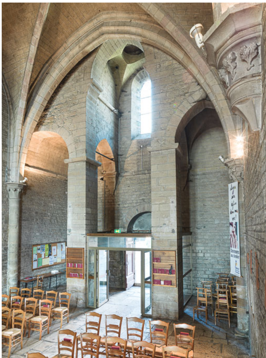
Vue du massif de maçonnerie soutenant le clocher.
