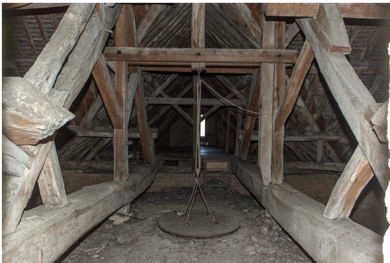
Combles, vue prise au-dessus de la croisée.
