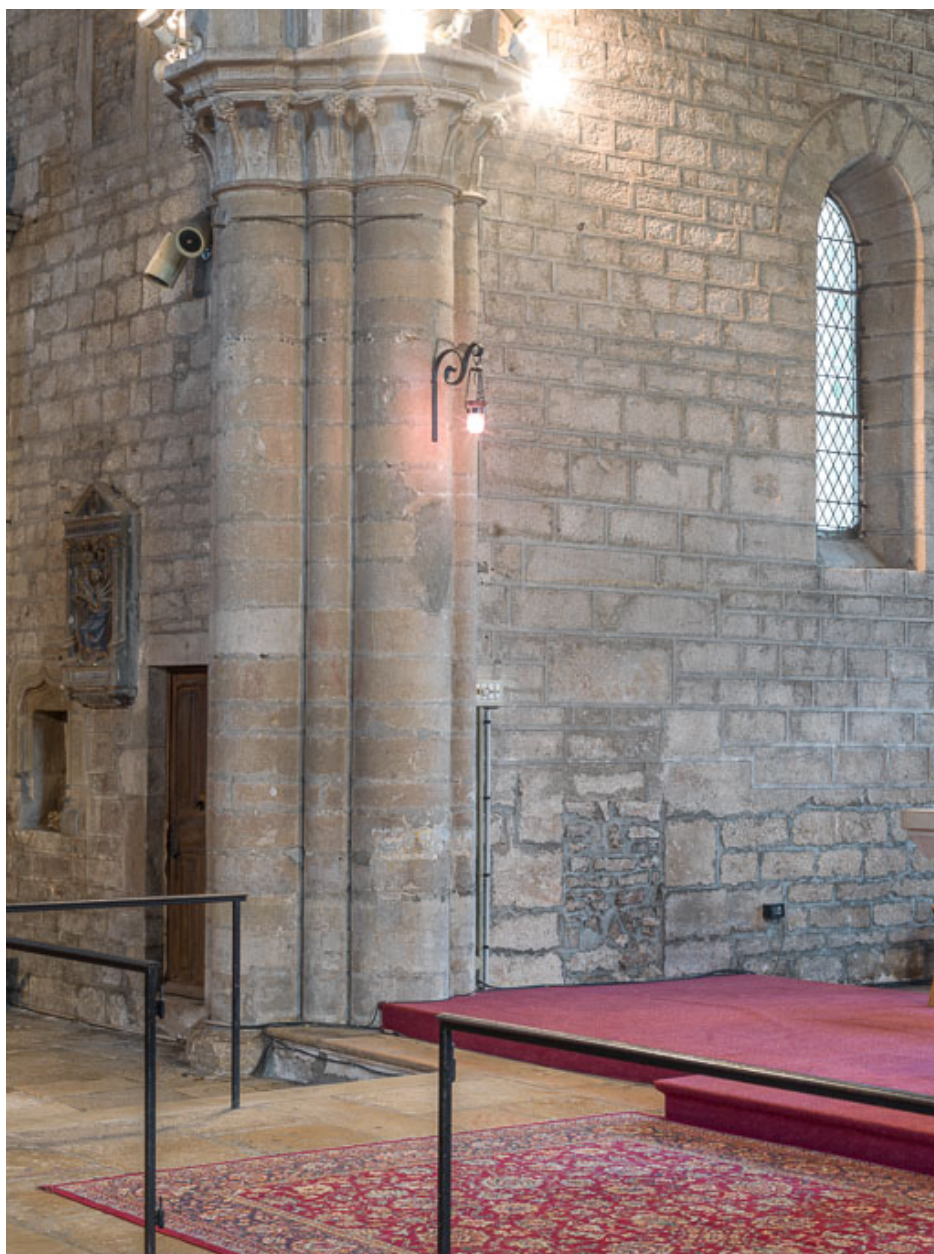
Vue d'un pilier de la croisée.
