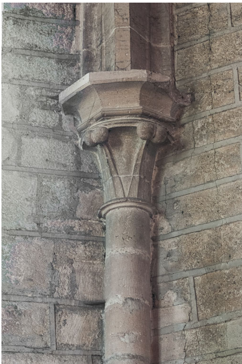
Vue d'un chapiteau du choeur.
