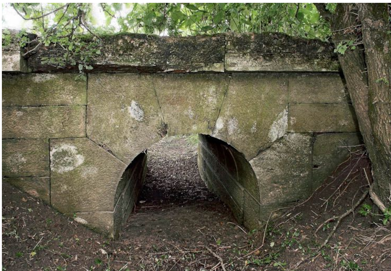
Ponceau, vue rapprochée.
