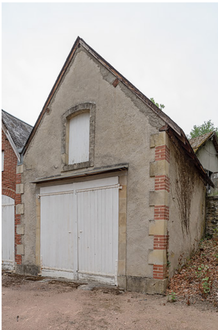
Mur-pignon du corps de droite.
