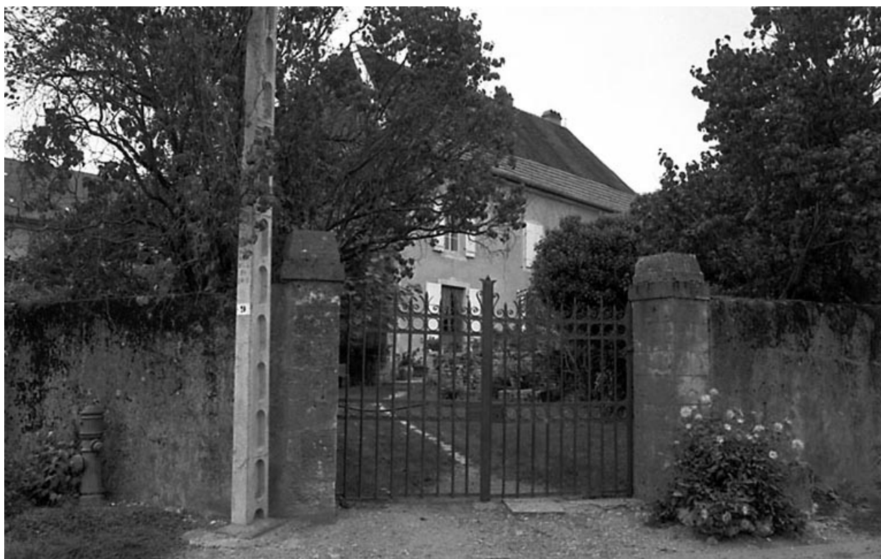
Maison située rue de la Fontaine.
