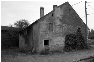
Maison située Grande Rue. Phot. Bernard Lardière IVR43_19797000030Z
