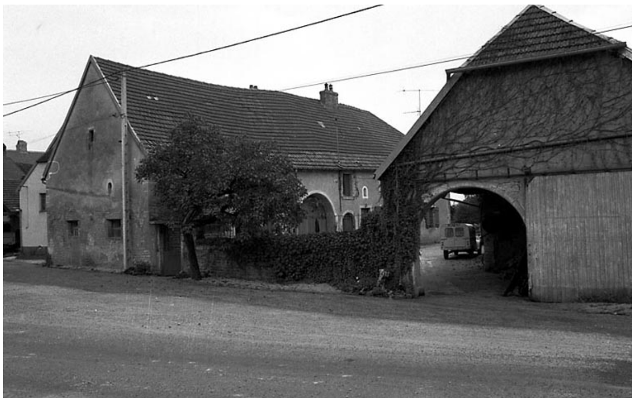
Maison de vigneron située impasse de l'Eglise.
