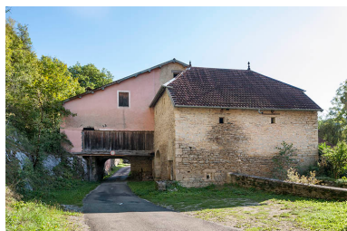
Façade ouest du moulin. Phot. Jérôme Mongreville IVR43_20152501827NUC4A
