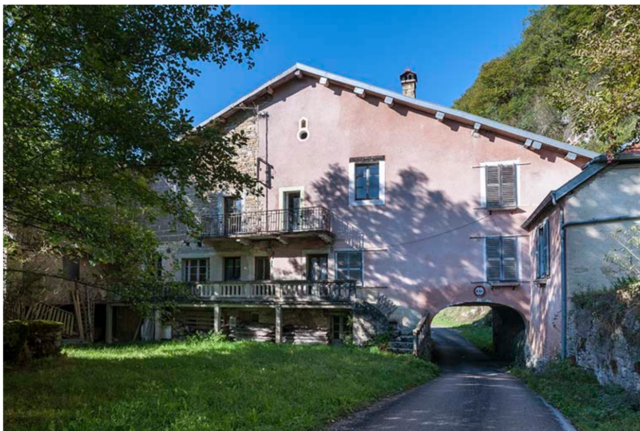
Façade est du moulin.
