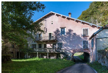
Façade est du moulin. Phot. Jérôme Mongreville IVR43_20152501825NUC4A
