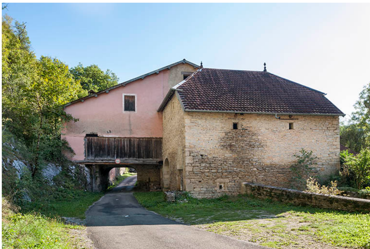
Façade ouest du moulin.
