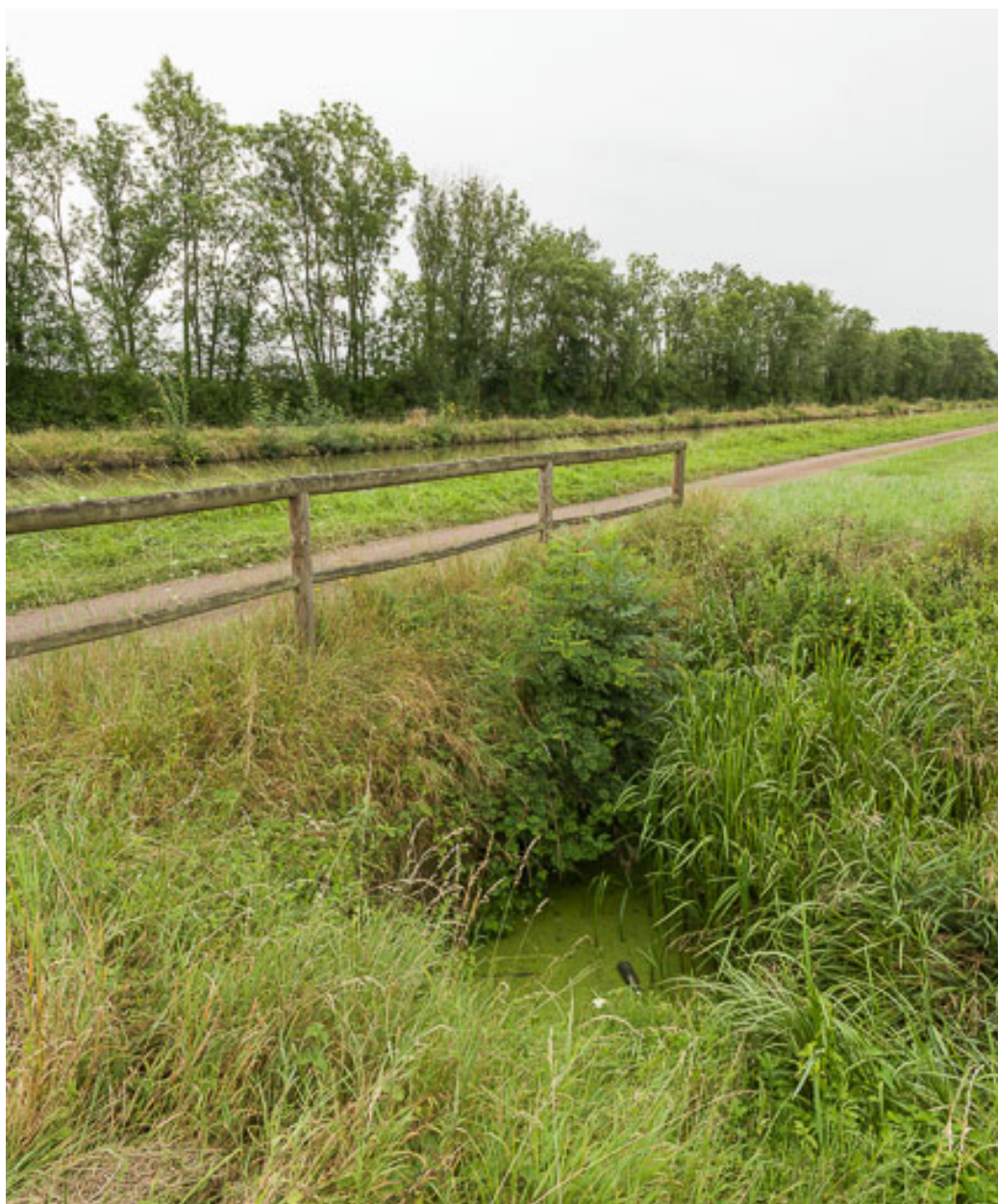
Vue de l'aqueduc.
