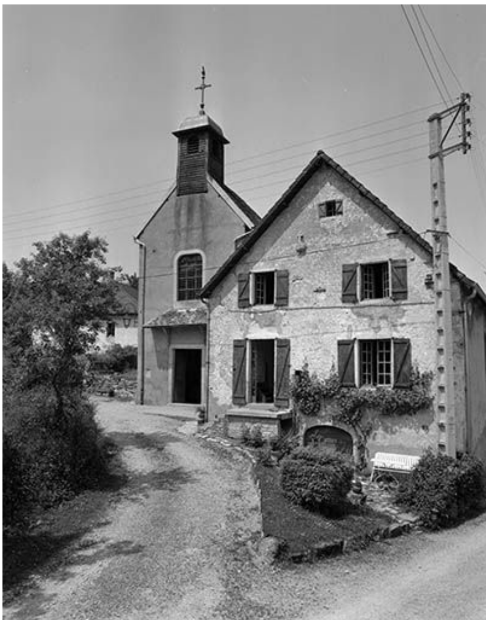
Maison située rue Ferdinand de Rye.
