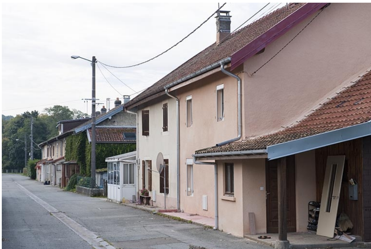
Habitations de 10 et 4 logements.
