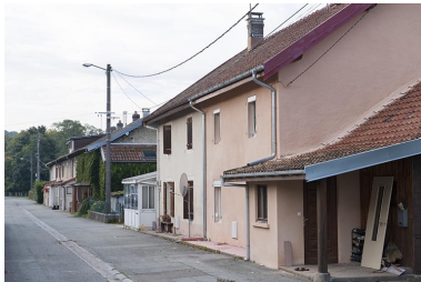
Habitations de 10 et 4 logements. Phot. Jérôme Mongreville IVR43_20122501833NUC4A
