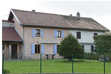
Habitation de 4 logements. Façade ouest. Phot. Jérôme Mongreville IVR43_20122501830NUC4A
