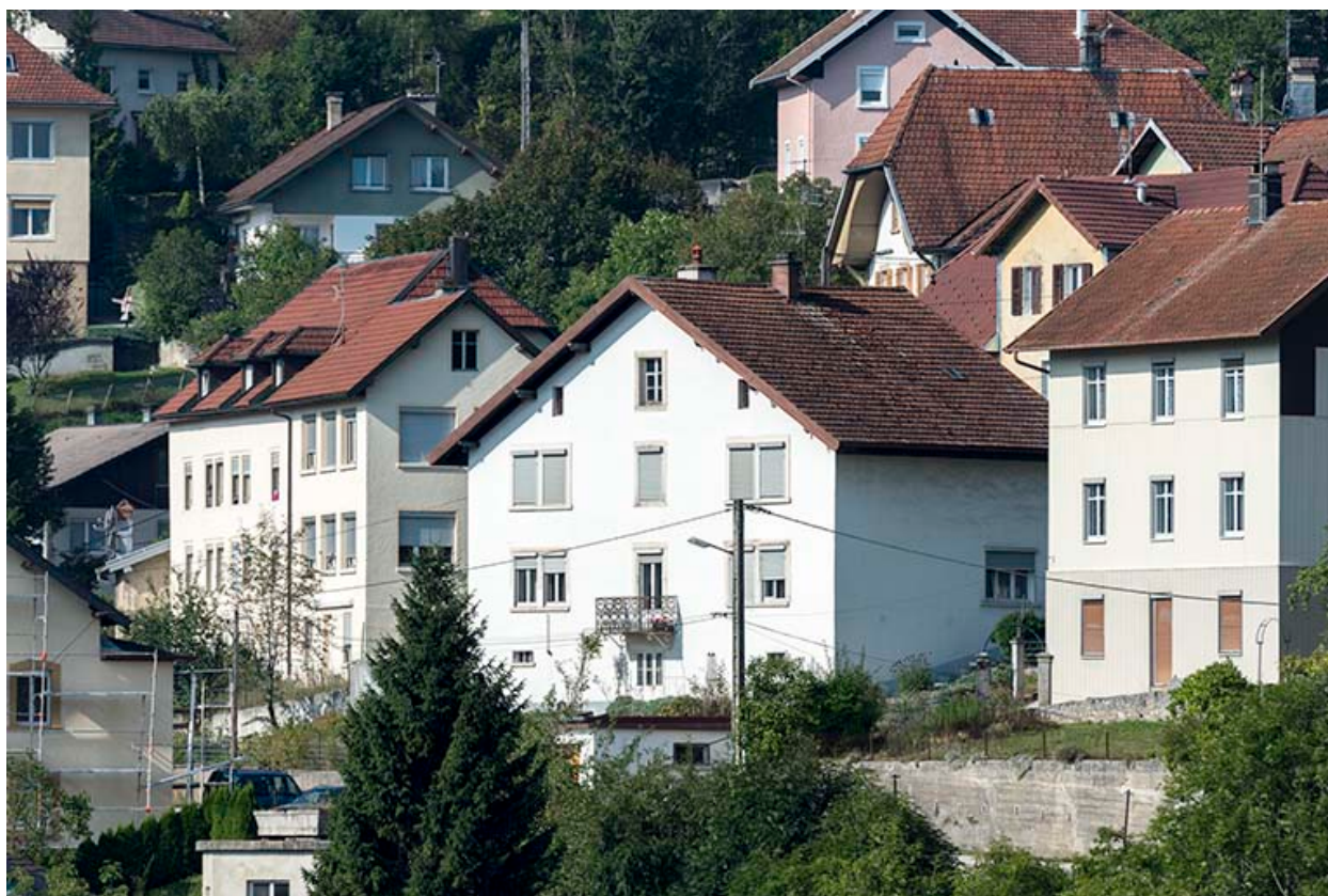
Façades postérieure et latérale gauche.
