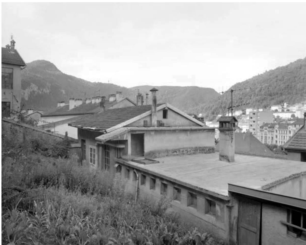
Façade postérieure des ateliers de fabrication.
