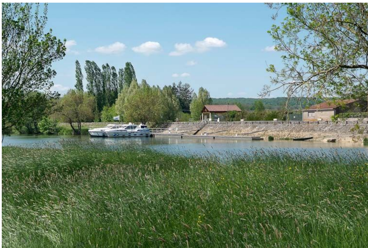
Digue protégeant La Truchère, avec port.
