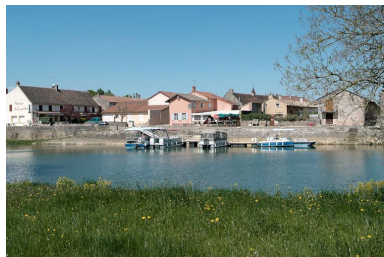
Digue protégeant La Truchère, avec port. Phot. Jean-Luc Duthu IVR26_20107100528NUC2A
