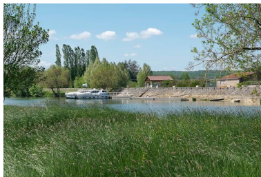
Digue protégeant La Truchère, avec port. Phot. Jean-Luc Duthu IVR26_20107100511NUC2A
