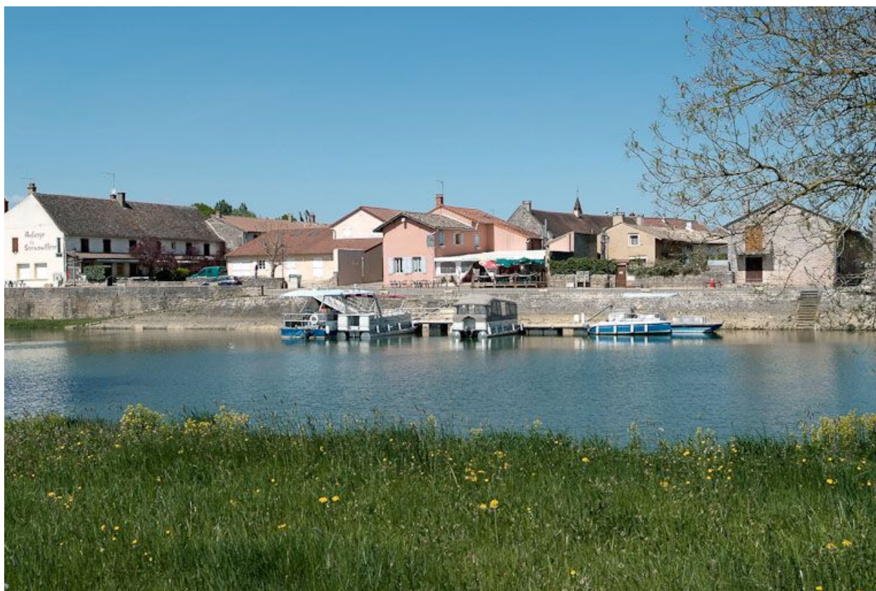
Digue protégeant La Truchère, avec port.
