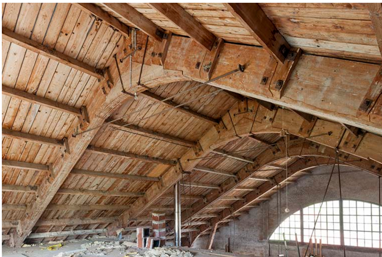
Vue désaxée de la charpente.
