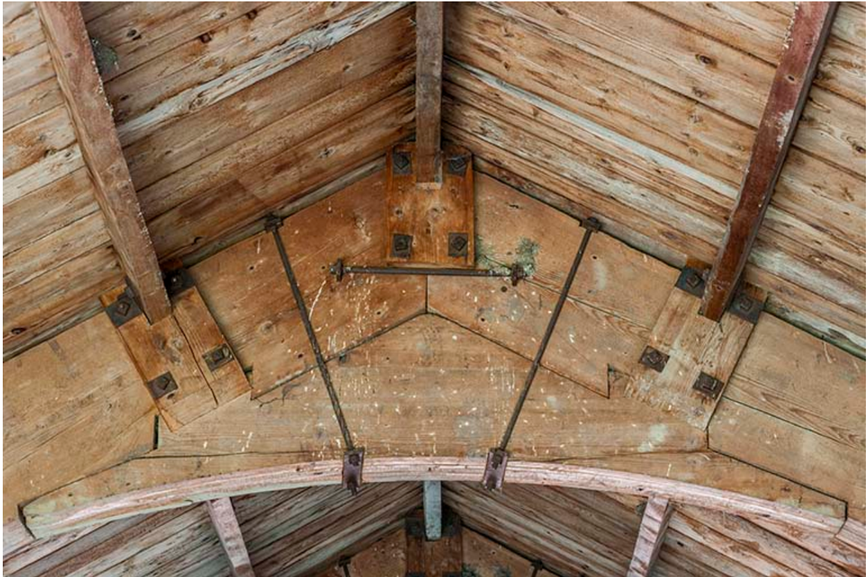
Détail de la jonction d'une ferme.
