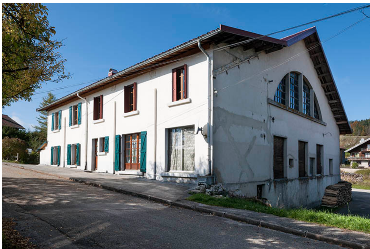
Vue depuis le sud.
