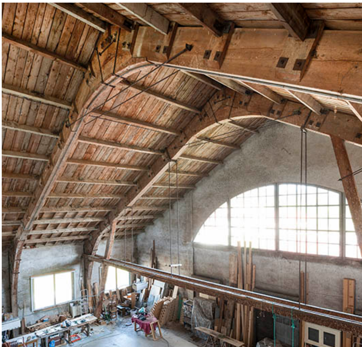
Vue d'ensemble de la charpente.
