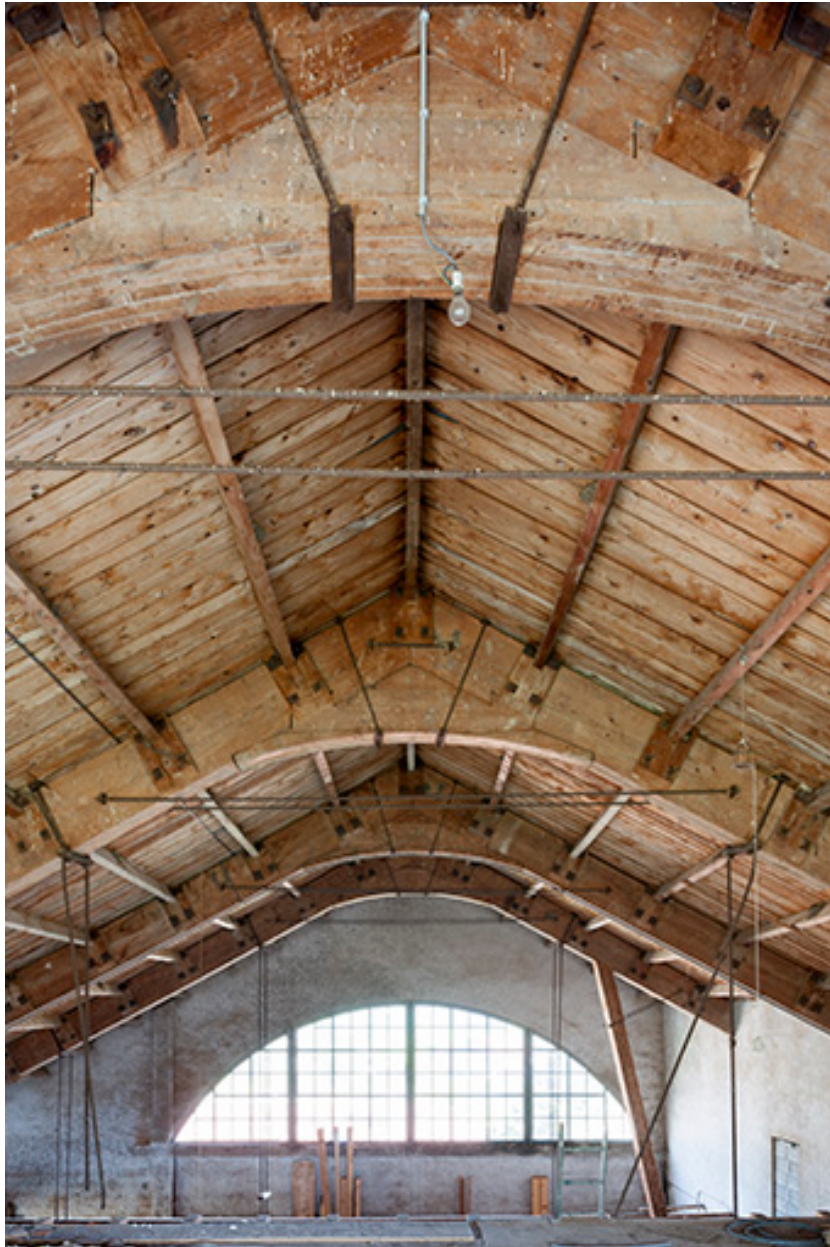
Vue axiale de la charpente, depuis l'ouest.
