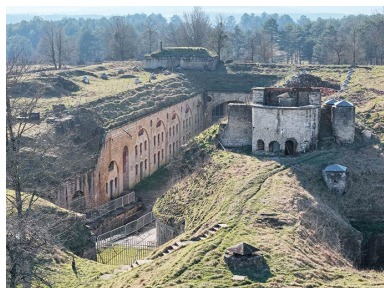
Les casernes (à gauche) et la tour de transmission (à droite), vues de trois quarts. (vue aérienne). Phot. Nicolas Douriaux IVR26_20262100386NUC4A
