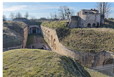
Les casernes (à gauche) et la tour de transmission (à droite). (vue aérienne). Phot. Nicolas Douriaux IVR26_20262100383NUC4A
