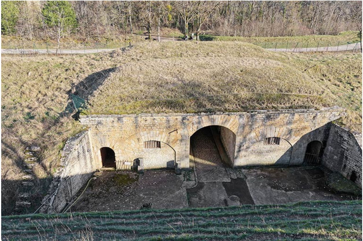
La gorge du bâtiment d'entrée. (vue aérienne).
