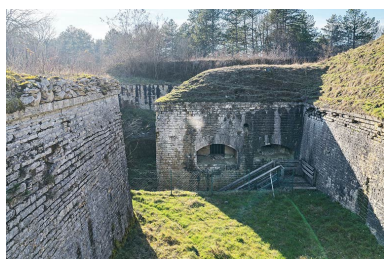
La caponnière (ou aileron) au saillant 2. (vue aérienne). Phot. Nicolas Douriaux IVR26_20262100391NUC4A
