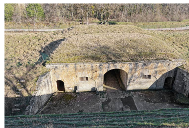
La gorge du bâtiment d'entrée. (vue aérienne). Phot. Nicolas Douriaux IVR26_20262100400NUC4A
