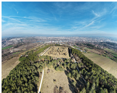
Le fort sur son plateau et surplombant la ville. (vue aérienne). Phot. Nicolas Douriaux IVR26_20262100338NUC4A
