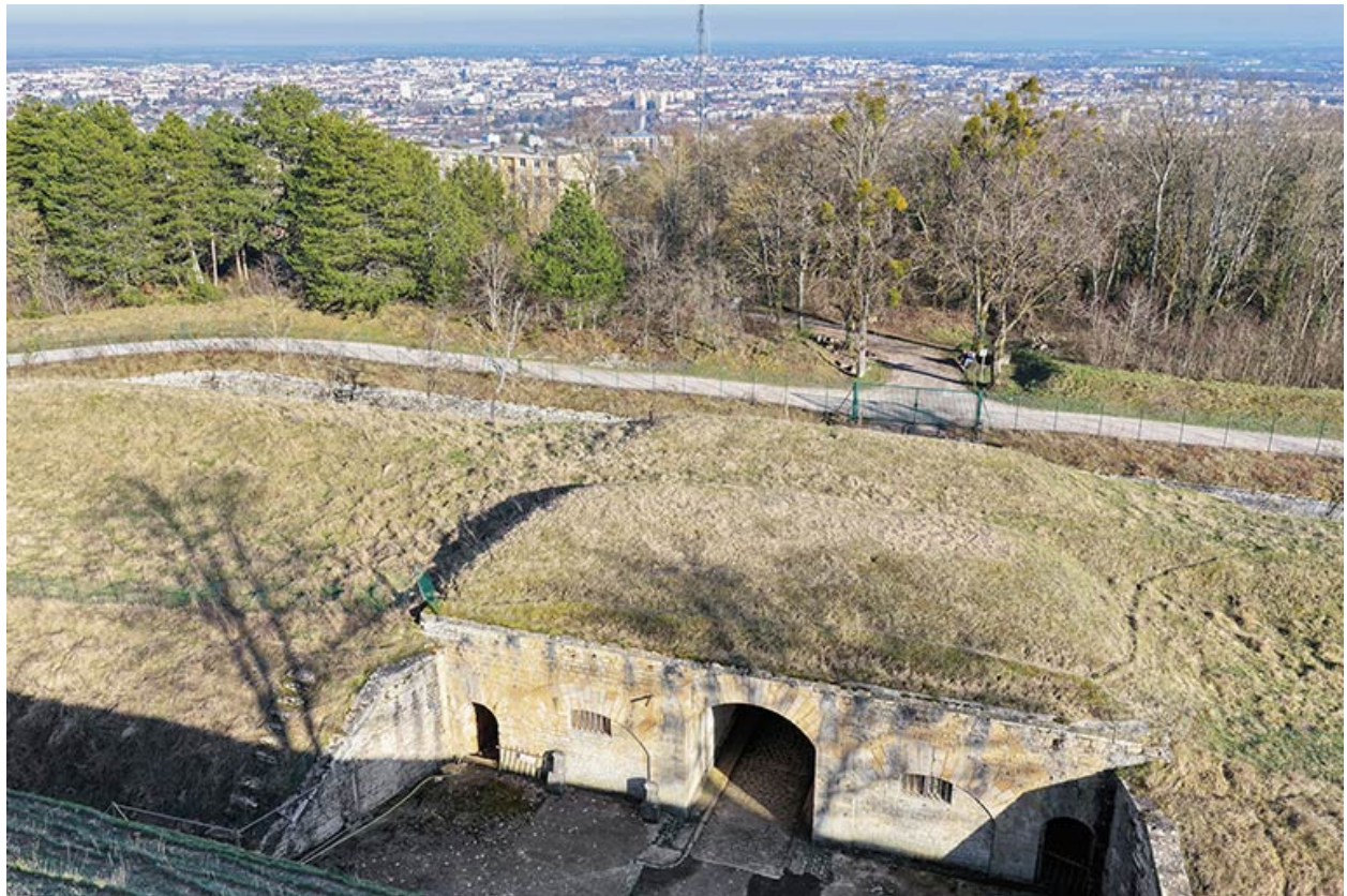
Le bâtiment d'entrée et la ville en arrière-plan. (vue aérienne).
