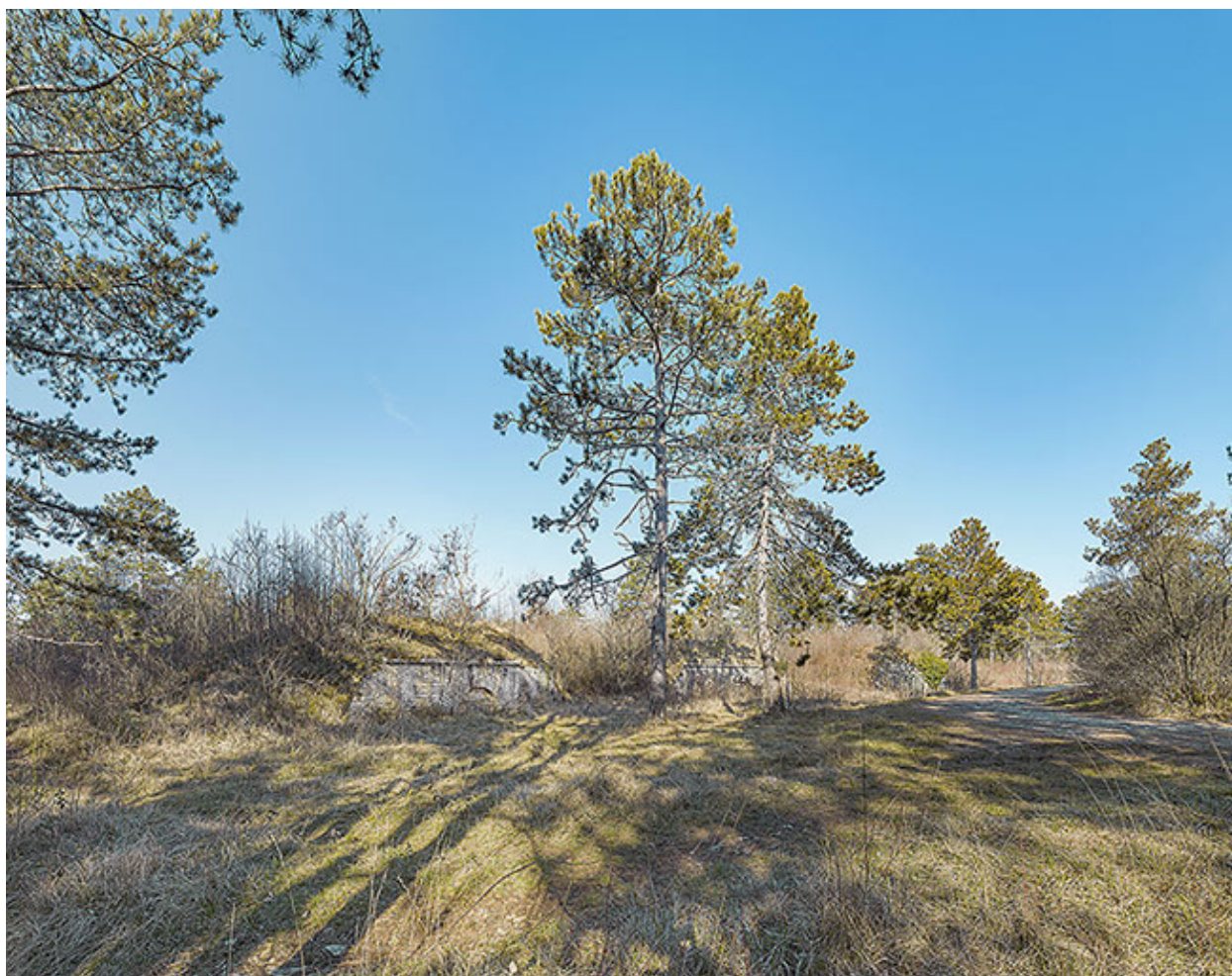
Les batteries annexes.
