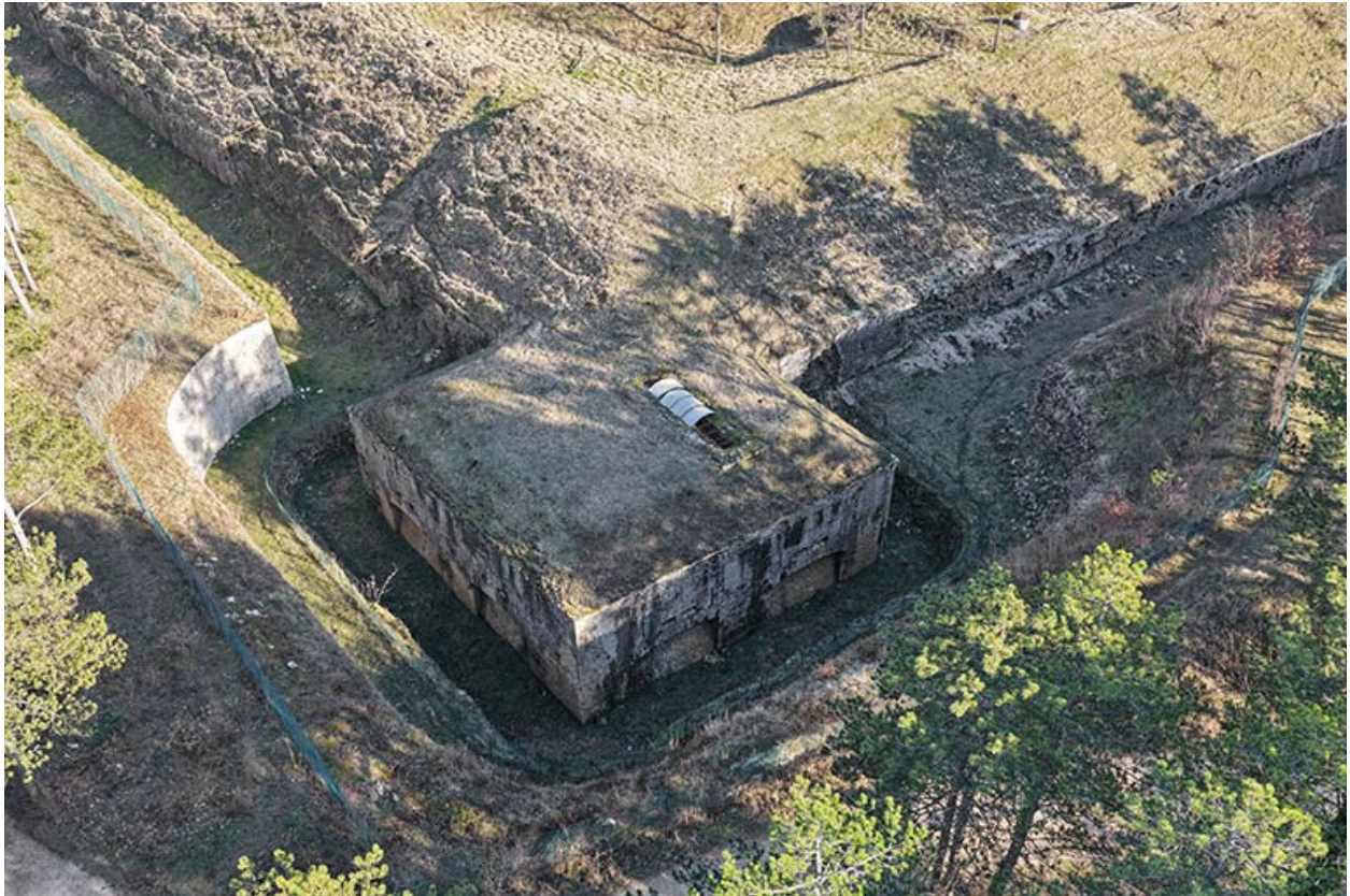
La double caponnière, au saillant 3. (vue aérienne).
