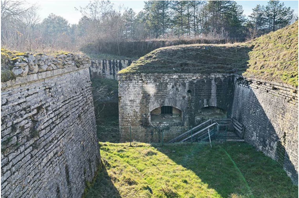
La caponnière (ou aileron) au saillant 2. (vue aérienne).
