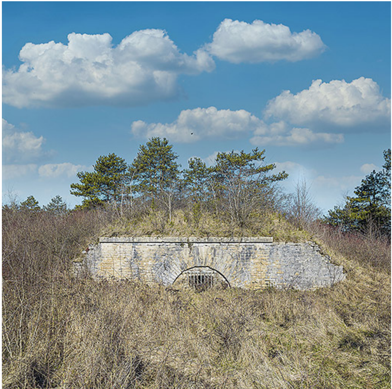
Une des batteries dépendantes du fort.
