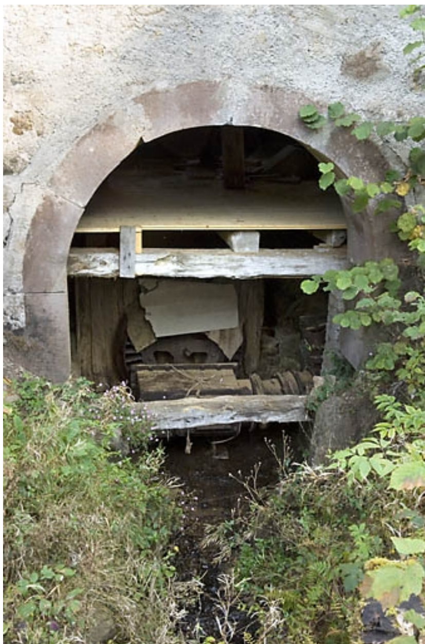
Ouverture cintrée et turbine Wiedeman Frères.
