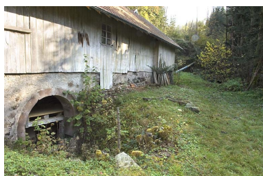
Façade occidentale. A gauche : ouverture en plein-cintre abritant la turbine. Phot. Jérôme Mongreville IVR43_20077000617NUCA
