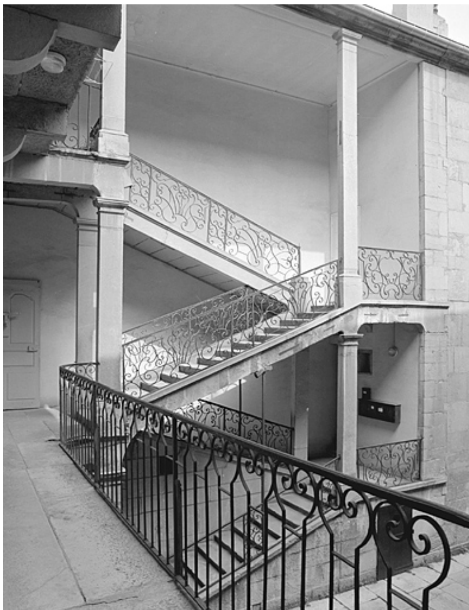
Escalier dans la cour.
