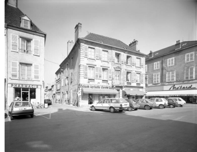
Façade antérieure et latérale gauche. Phot. Yves Sancey IVR43_19897000296V
