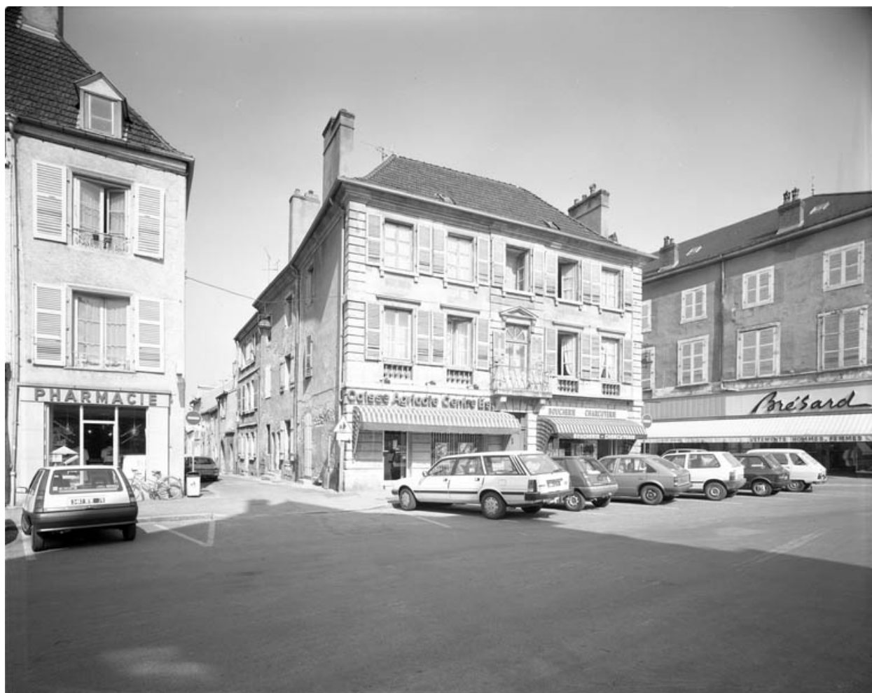
Façade antérieure et latérale gauche.
