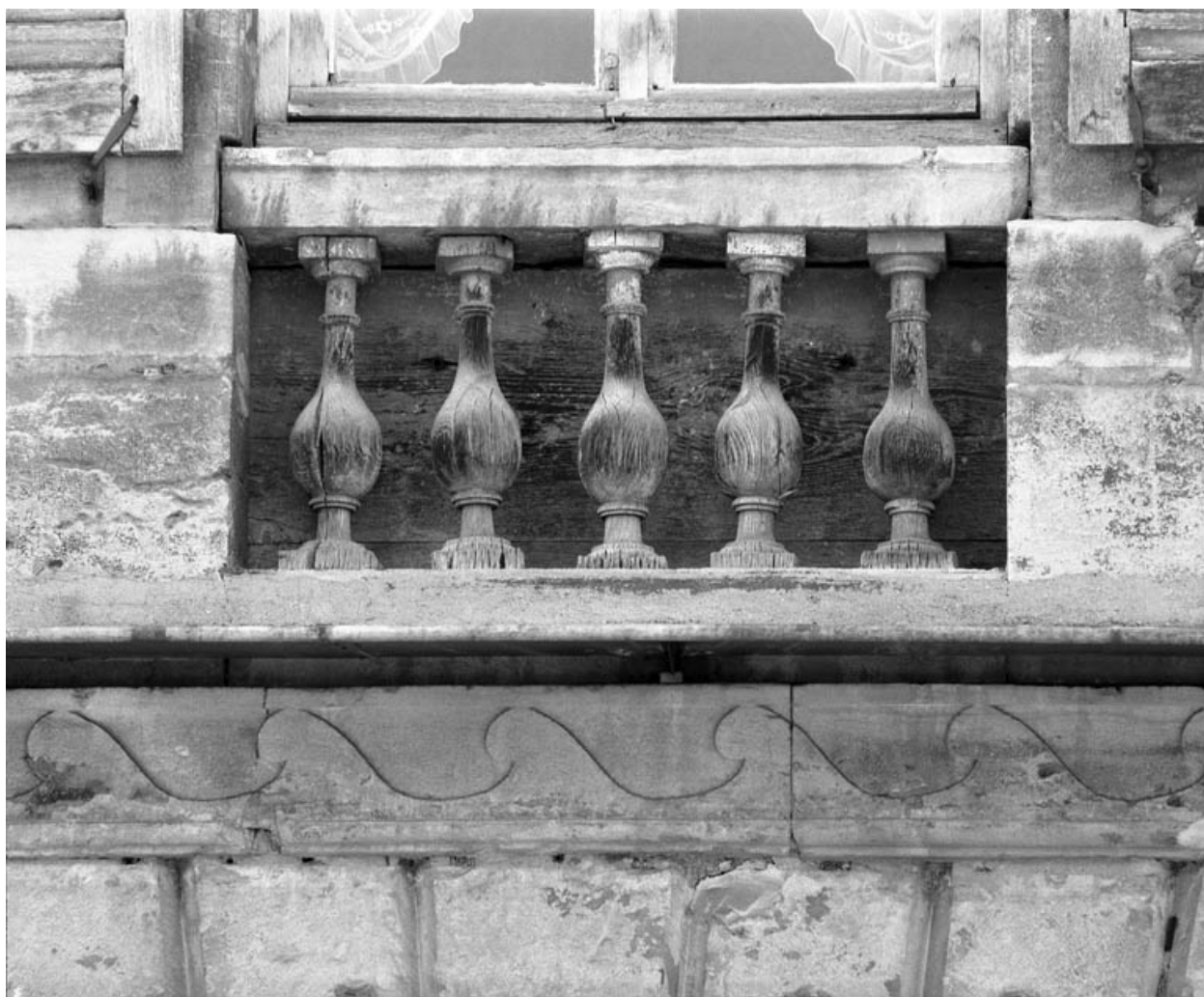
Façade antérieure : détail d'un garde-corps.
