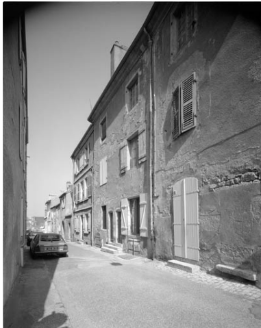
Façade latérale gauche. Phot. Yves Sancey IVR43_19897000273V
