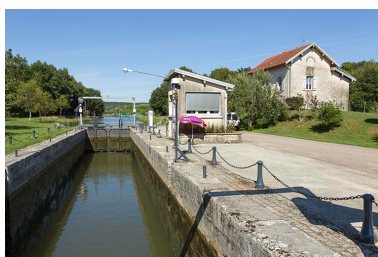
L'écluse à sas. Phot. Sonia Dourlot IVR43_20157000777NUC2A
