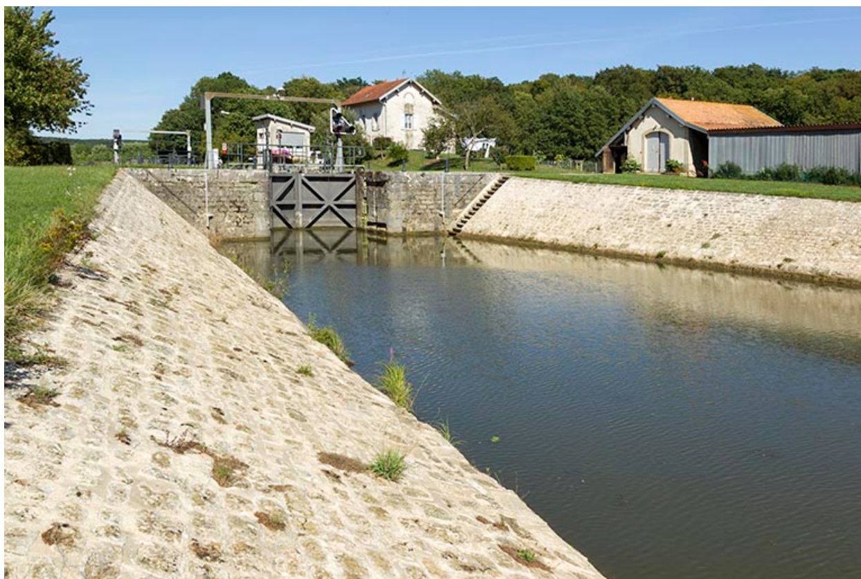
Vue aval du site d'écluse.
