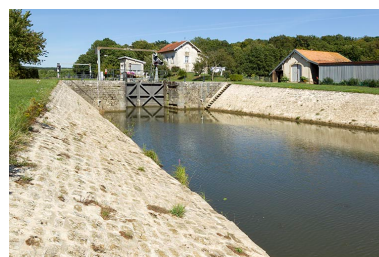
Vue aval du site d'écluse. Phot. Sonia Dourlot IVR43_20157000781NUC2A
