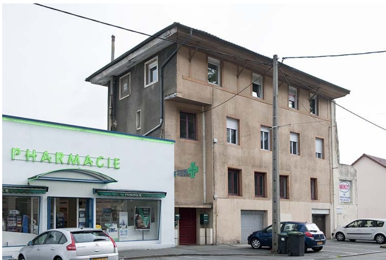
Vestiges de l'atelier depuis la rue.
