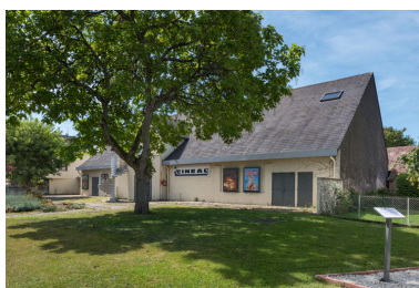
Cinéma, de trois quarts droite. Phot. Pierre-Marie Barbe-Richaud IVR26_20235800227NUC4A
