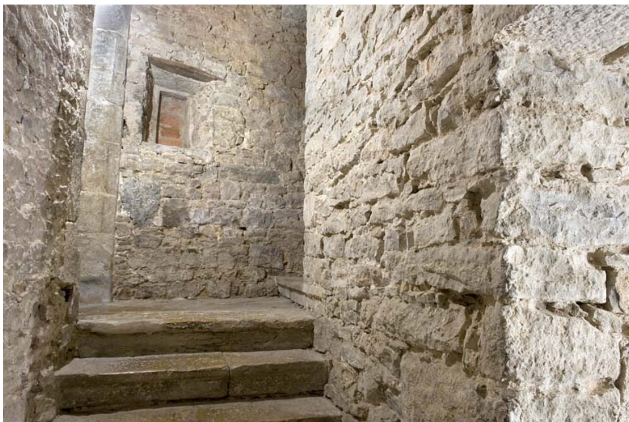
Escalier dans-oeuvre desservant les étages.
