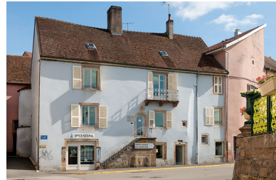
Vue rapprochée. Phot. Jérôme Mongreville IVR43_20102500672NUC4A
