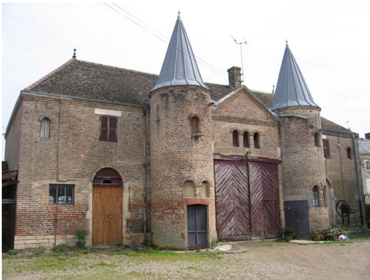
Vue d'ensemble de la façade.
