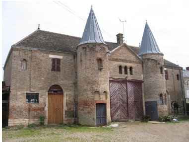
Vue d'ensemble de la façade.
