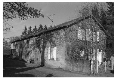
Ecuries et logement, vus depuis le canal. Phot. Frédéric Pillet IVR26_19997100845Z
