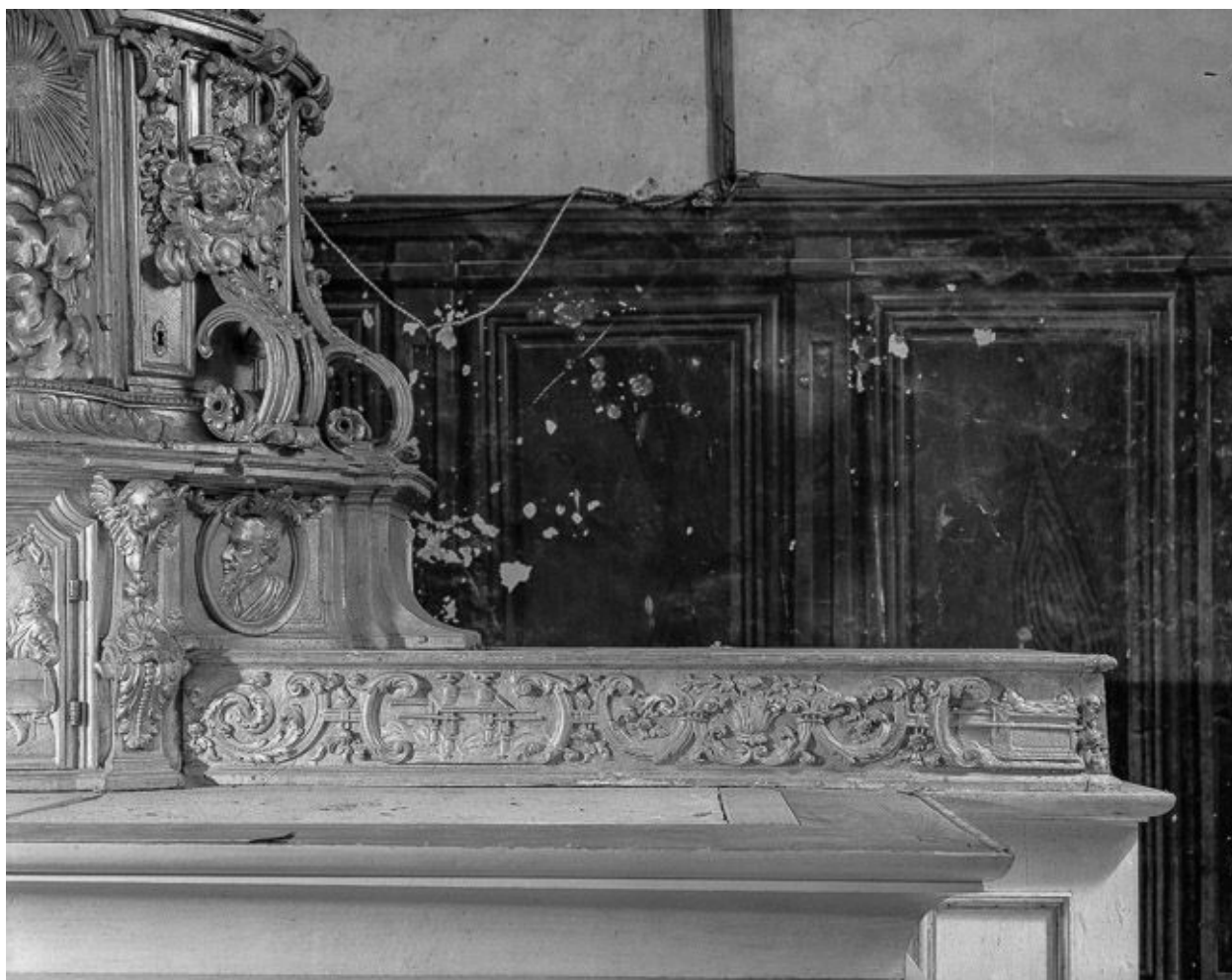
Détail : partie droite du gradin.
