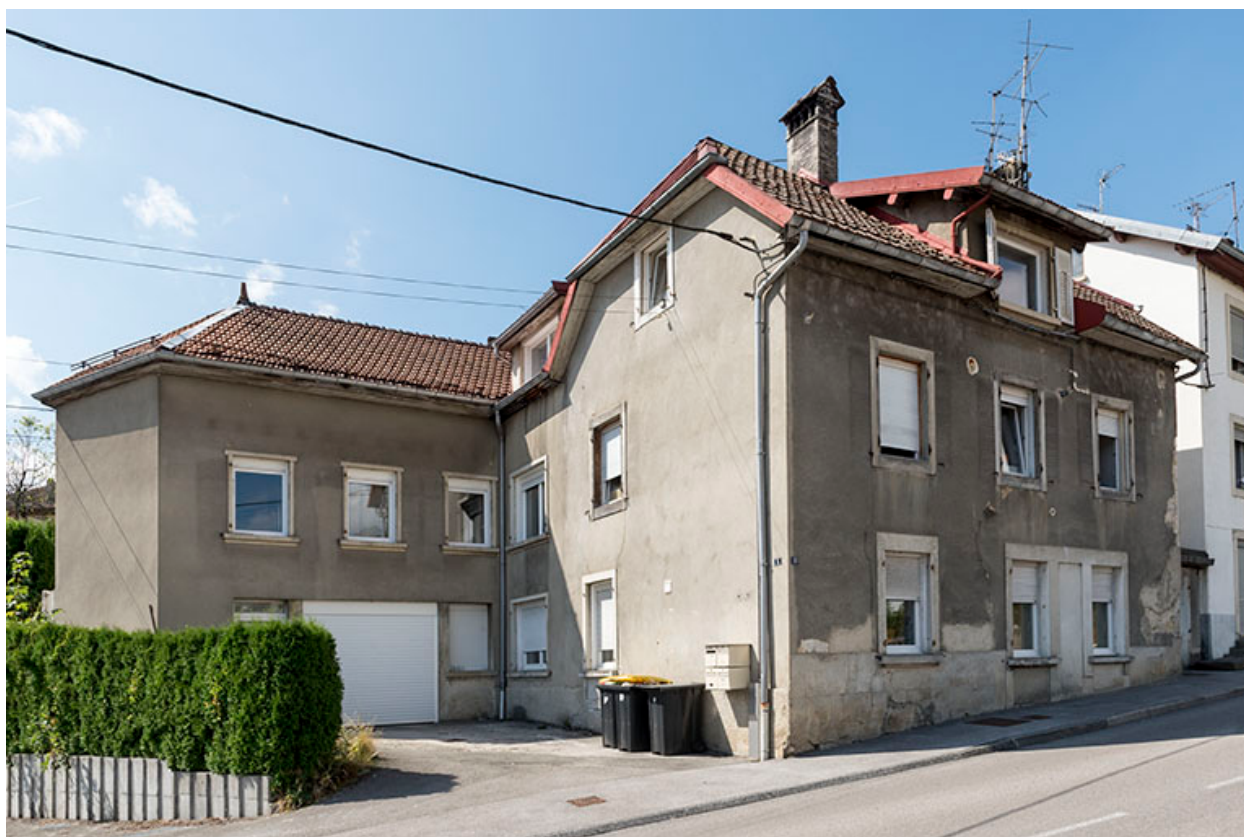
Façades antérieure et latérale gauche.
